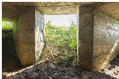
Vue intérieure avec, de gauche à droite, les entrées sud-est, sud et sud ouest Phot. Jean-Marc Ramette IVR31_20145905016NUCA
