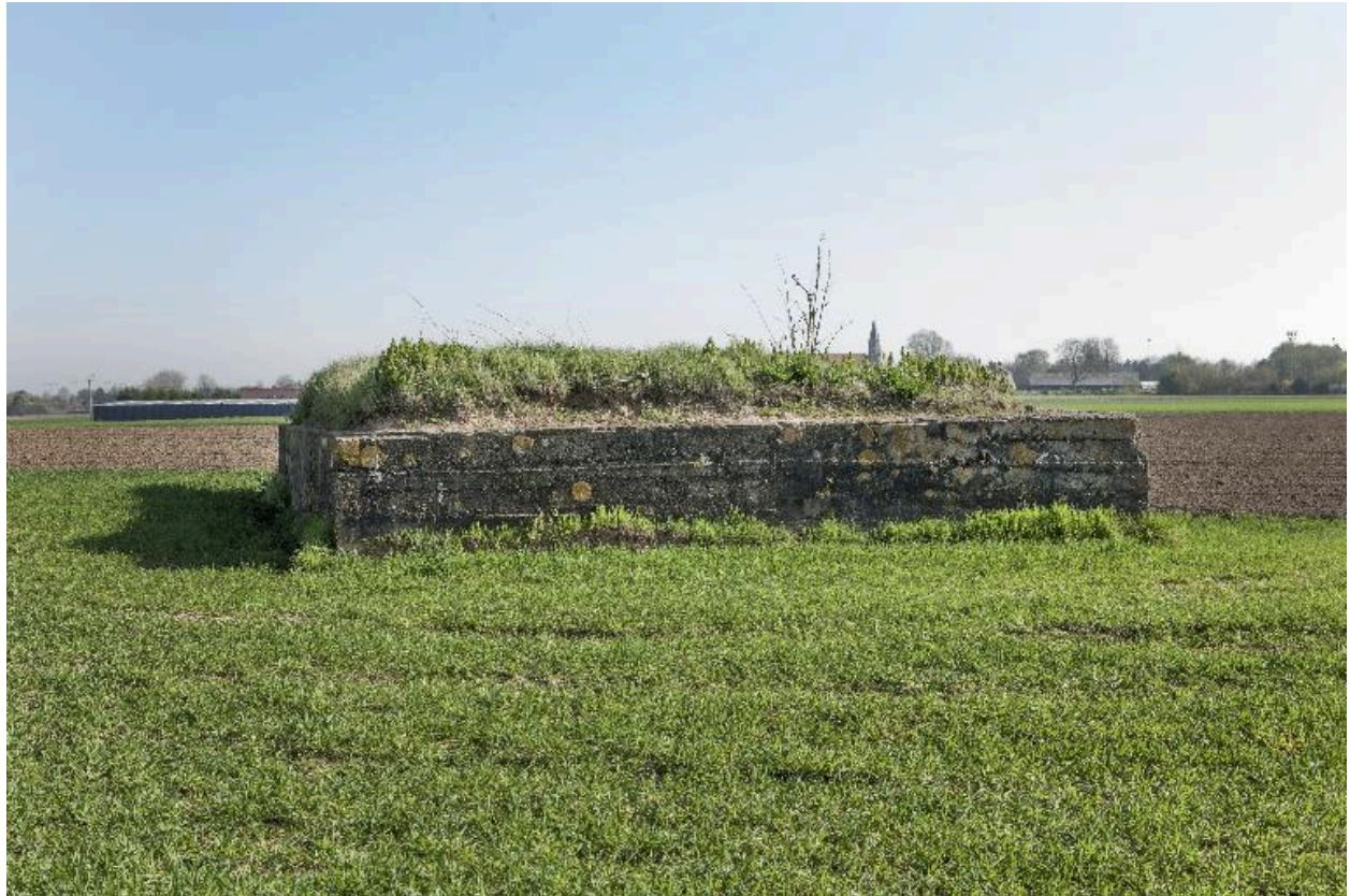
Vue générale vers le nord-est
