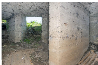
Vers l'entrée centrale, depuis la salle ouest Phot. Pierre Thibaut IVR31_20155901664NUCA
