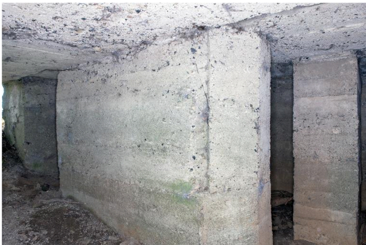
Couloir, vers l'entrée sud-est
