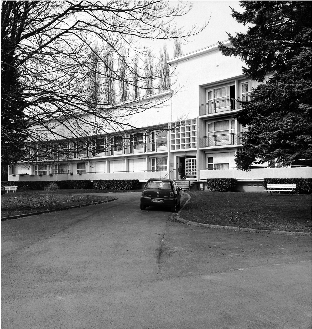
Élévation antérieure (sud) de l'immeuble incurvé.
