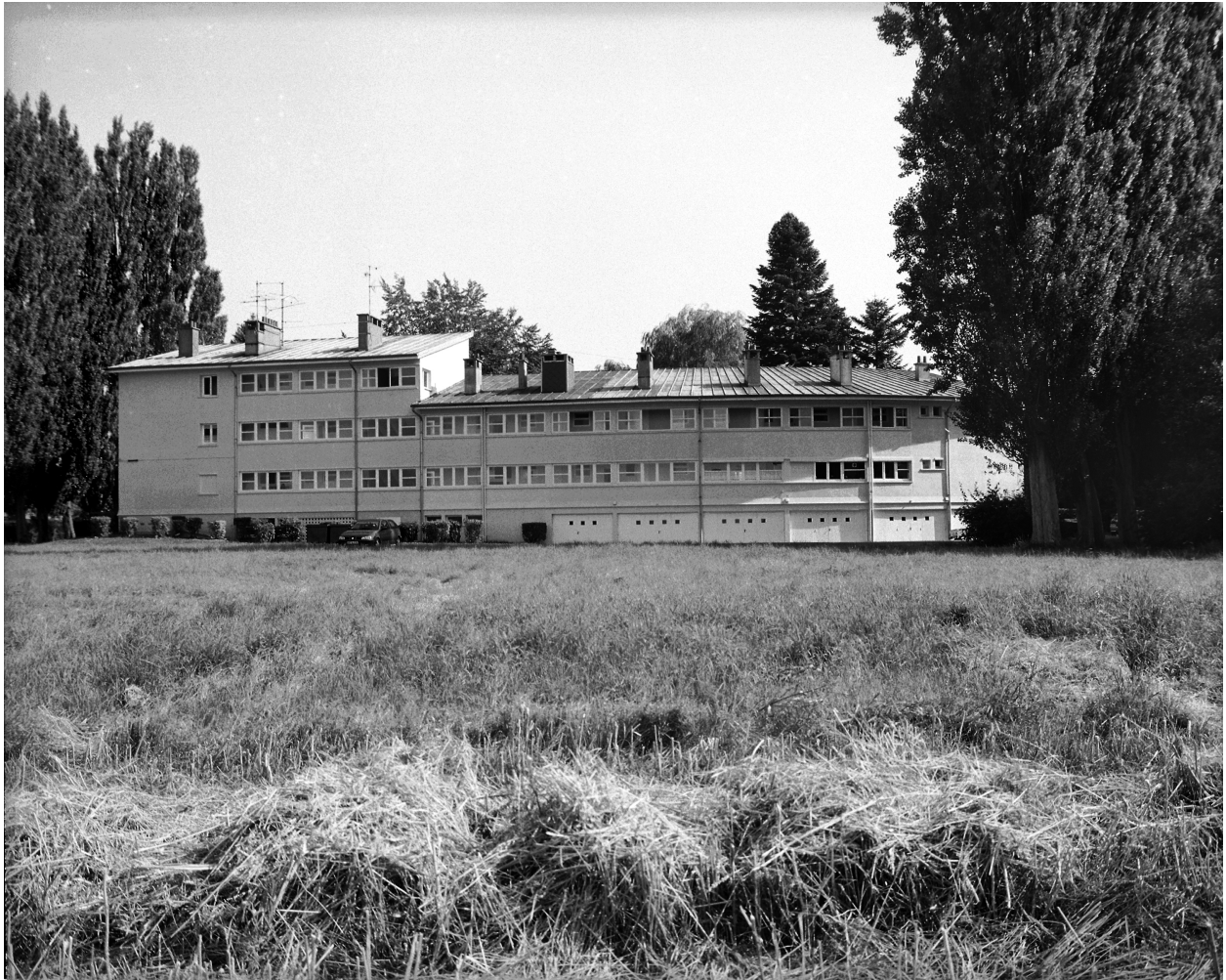
Élévation postérieure (nord) de l'immeuble incurvé.
