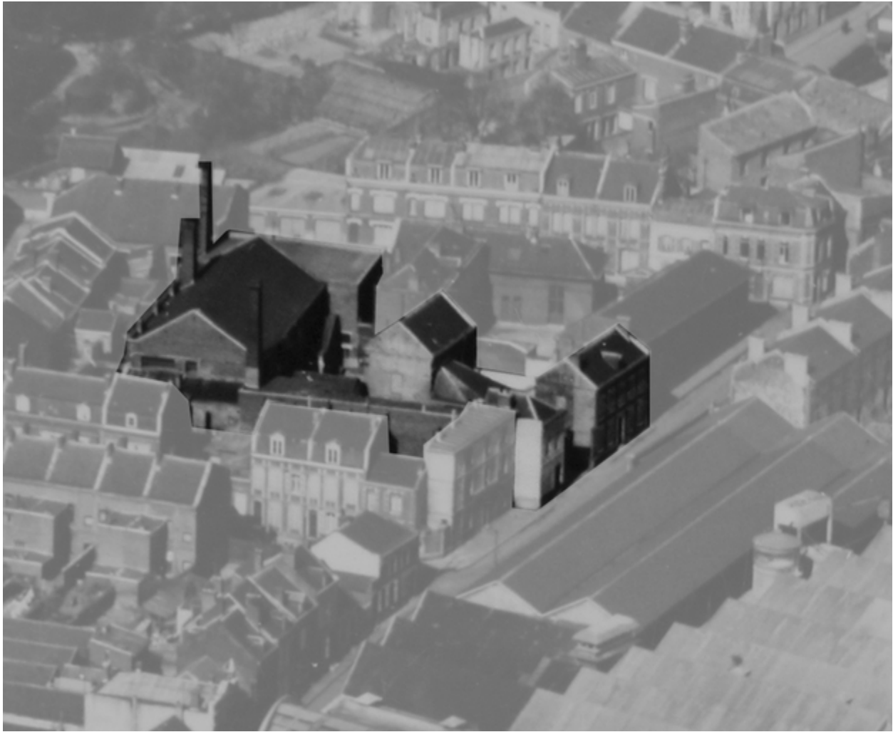
Vue aérienne du site au milieu des années 1930 (BM Saint-Quentin).
