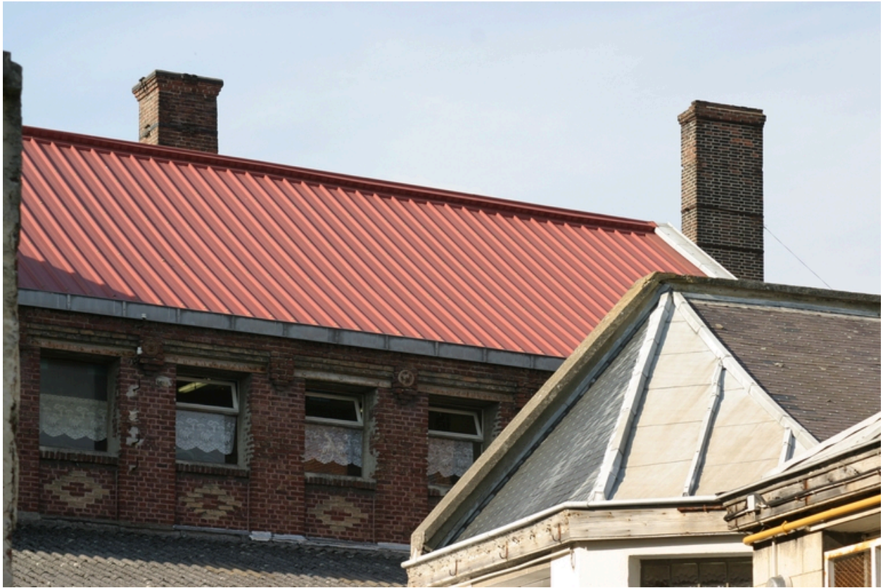
Magasin à farine (façade sur cour).
