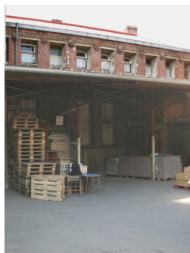
Fournil (rez-de-chaussée) et magasin à farine (étage). Phot. Frédéric Pillet IVR22_20050205581NUCA
