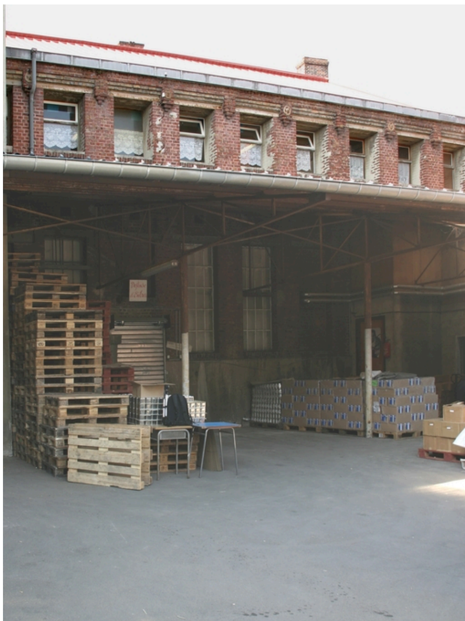
Fournil (rez-de-chaussée) et magasin à farine (étage).
