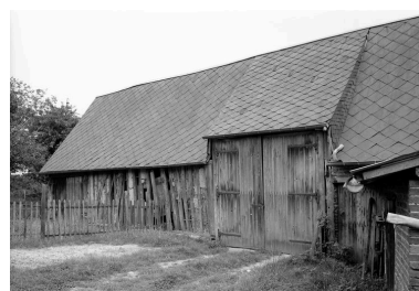
Ferme repérée rue du Puits. Détail de la grange. Phot. Jean-Michel Périn IVR22_19846001079X
