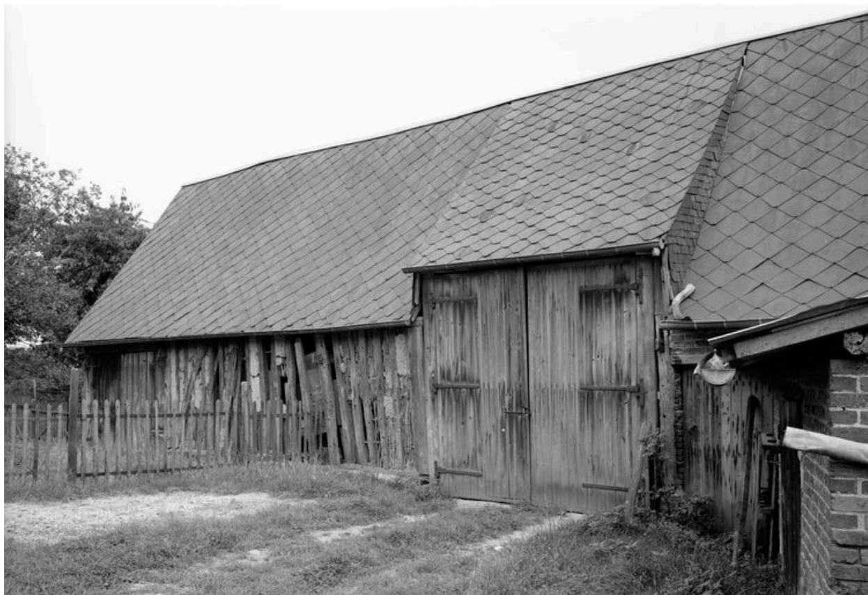
Ferme repérée rue du Puits. Détail de la grange.
