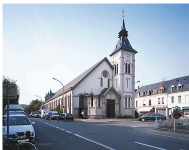
Vue générale. Phot. Philippe Dapvril IVR31_20046200118VA
