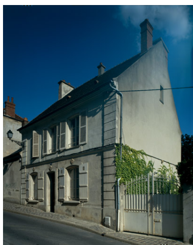
Maison, 24 rue Saint-Martin. Vue depuis la rue. Phot. Thierry Lefébure IVR22_19940200777VA
