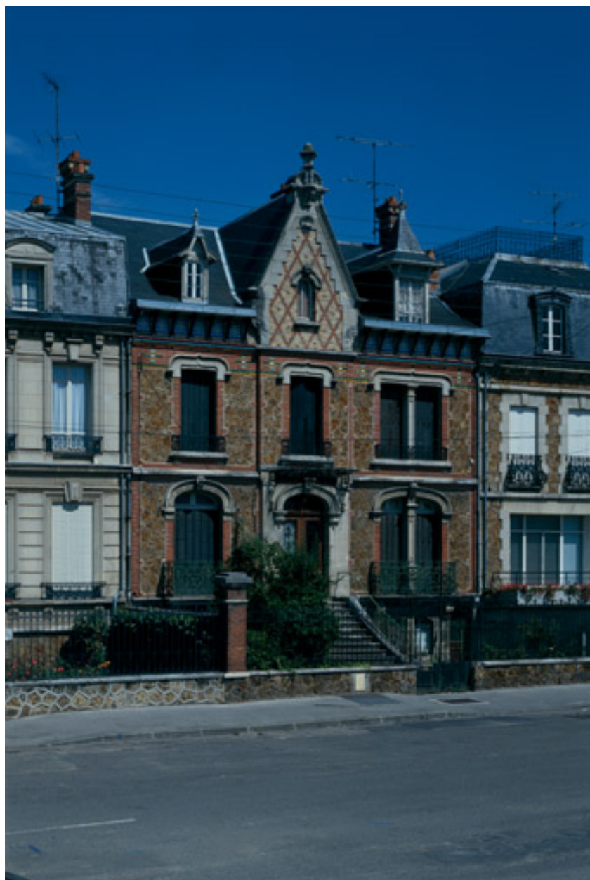
Maison, 10 place des Etats-Unis. Vue depuis la rue.
