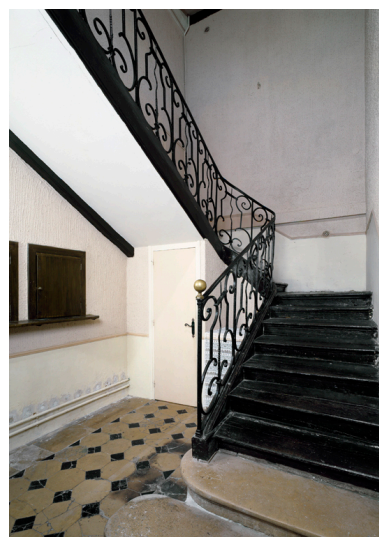
Hôtel, 9 rue Jean-de-La Fontaine. Vue de l'espacecier du logis en fond de cour. Phot. Thierry Lefébure IVR22_19940201162PA
