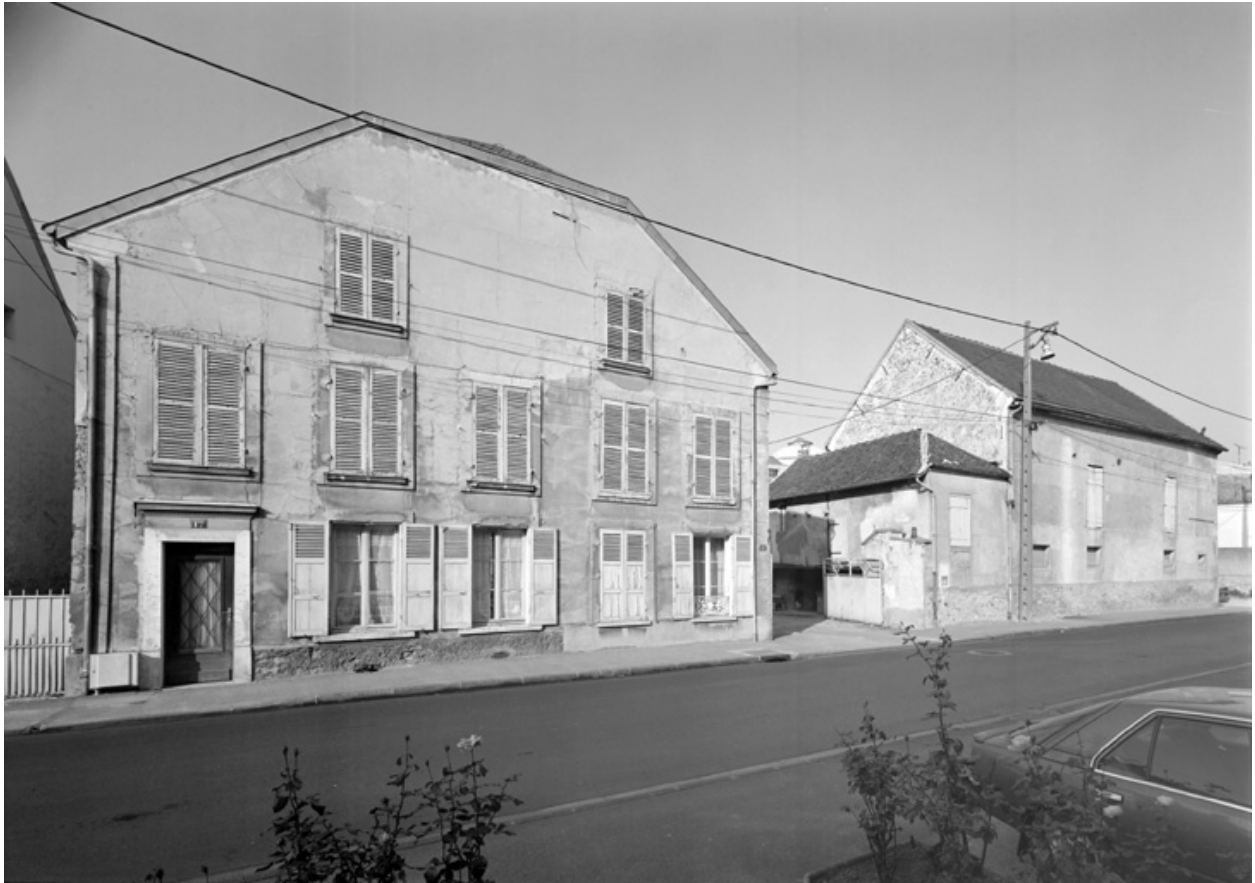
Ferme, 15 rue des Petits-Champs. Vue depuis la rue.
