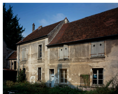
L'ancien presbytère, 19 rue Saint-Crépin. Phot. Thierry Lefébure IVR22_19940201013VA
