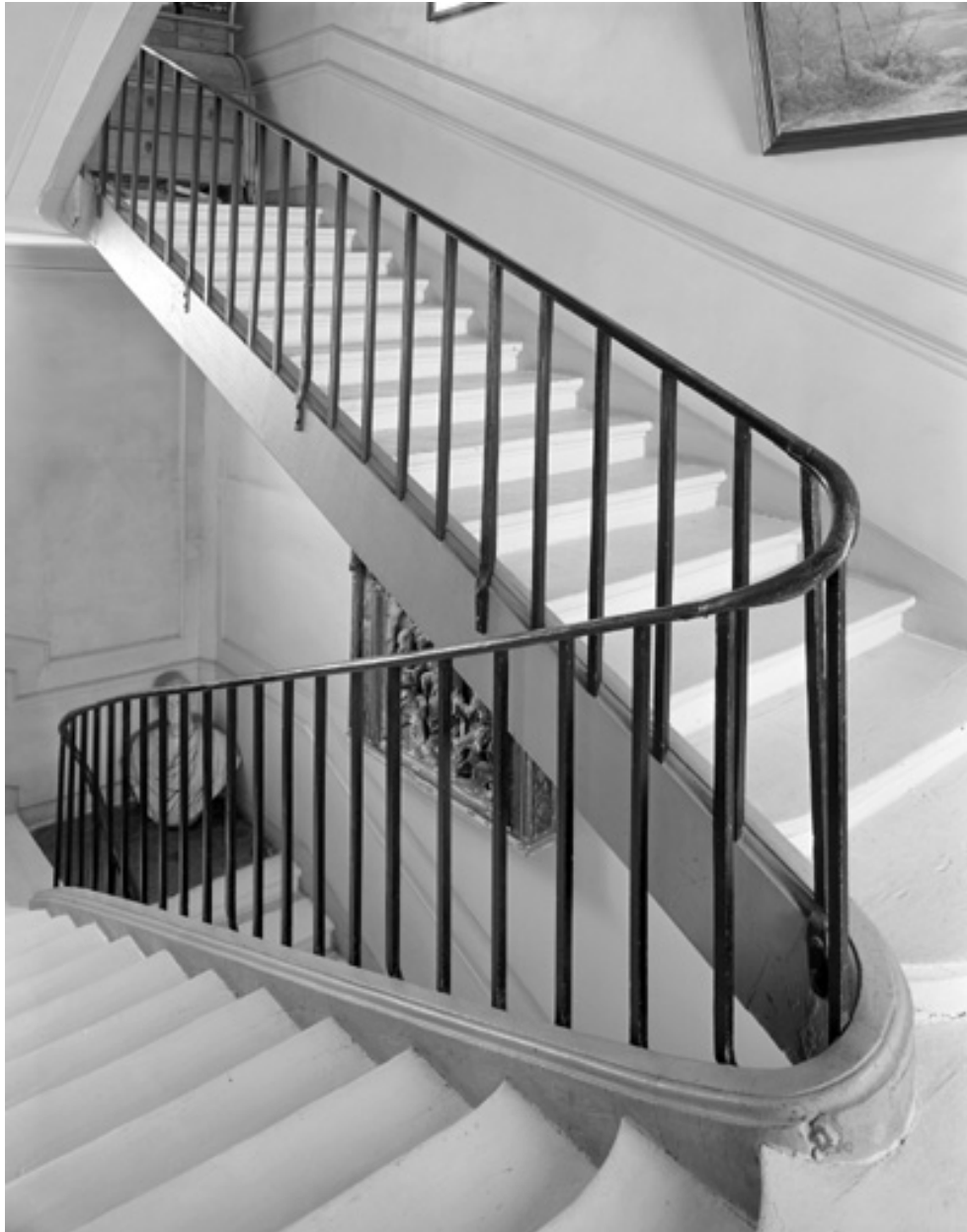
Hôtel, 33 rue du Château. Vue de l'escalier depuis le palier du premier étage.
