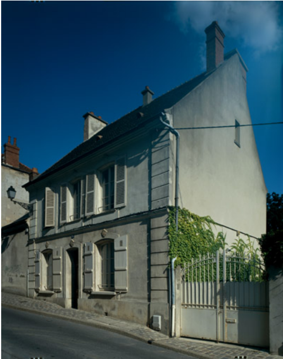
Maison, 24 rue Saint-Martin. Vue depuis la rue.
