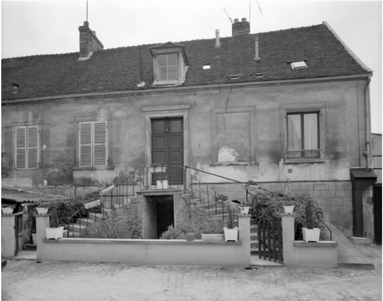
Maison, 41 rue Paul-Doucet. Vue de la façade principale sur cour.
