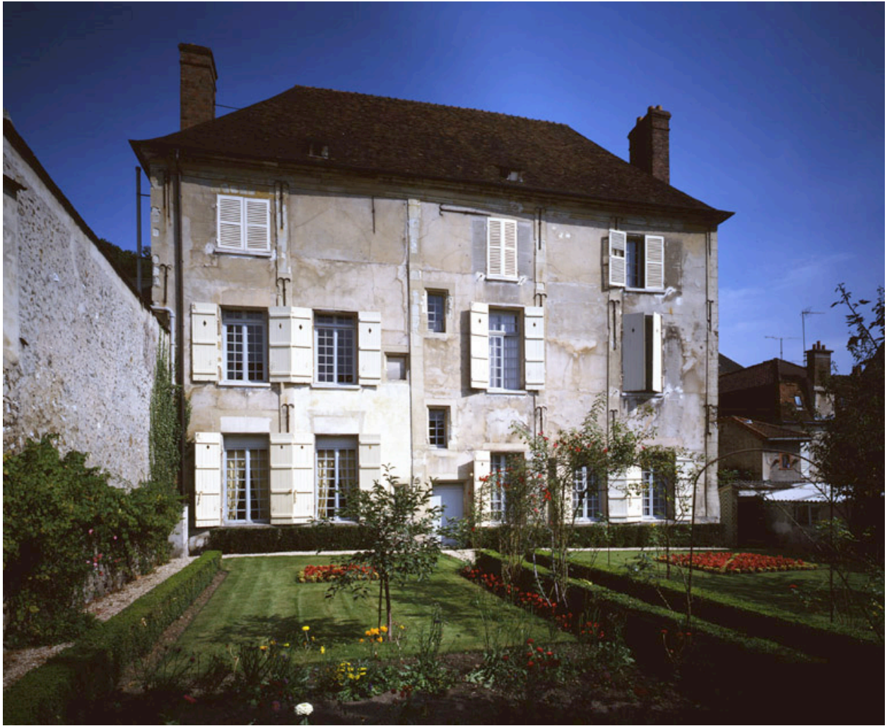
Hôtel, 12 rue Jean-de-La Fontaine. Façade sur le jardin.
