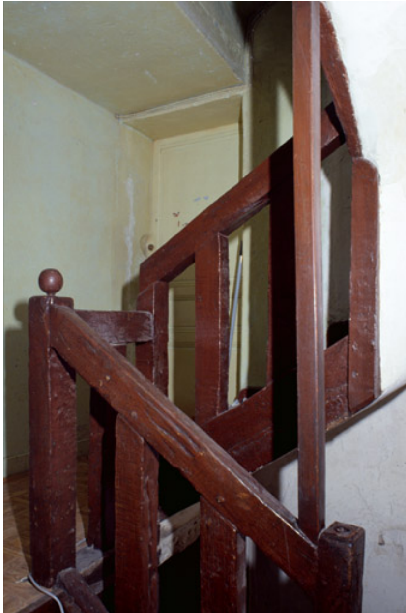
Maison, rue Saint-Crépin. Vue de l'escalier, prise au niveau du premier étage.
