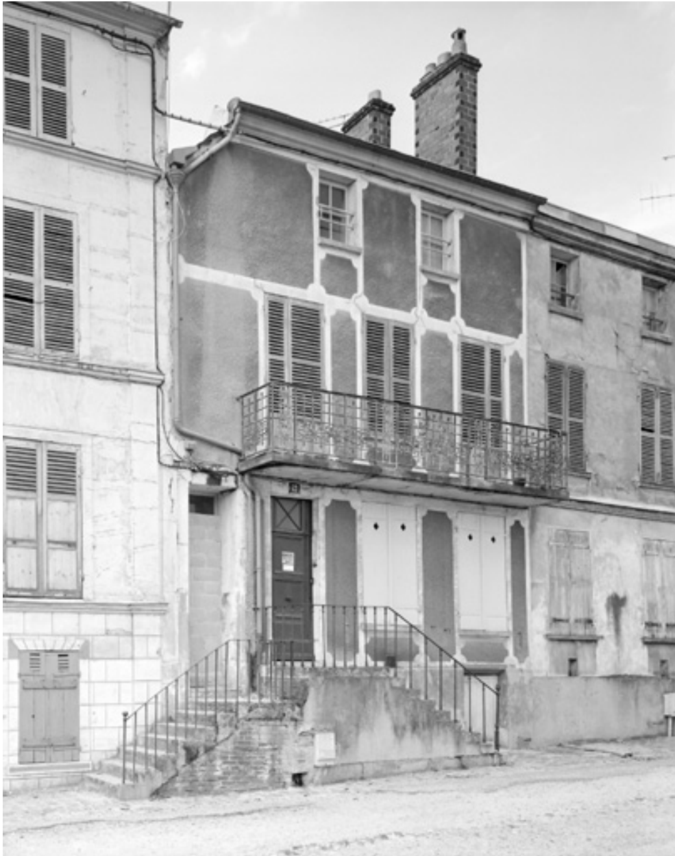
Maison, 12 avenue Joussaume-Latour.
