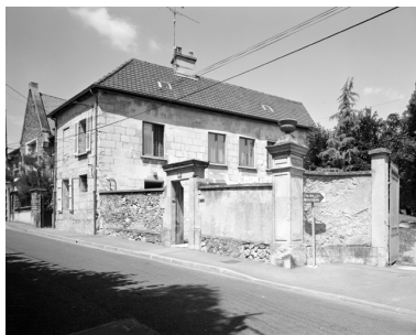
Ancien bureau d'octroi, 19bis rue Jules-Maciet. Vue de situation depuis la rue. Phot. Thierry Lefébure IVR22_19950200338V
