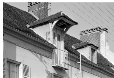
Lucarne monte-sacs surmontant la façade d'une ancienne boulangerie, 17 rue Paul Doucet. Phot. Thierry Lefébure IVR22_19940201234X
