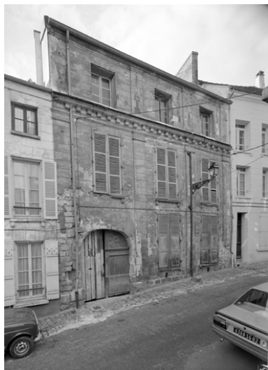
Hôtel, 32 rue du Château. Vue depuis la rue. Phot. Thierry Lefébure IVR22_19940201123P
