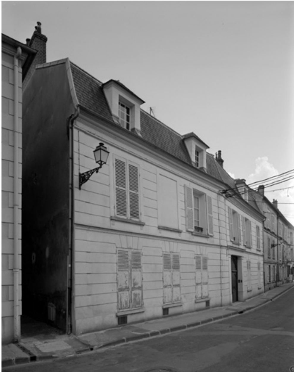
Hôtel, 32 rue Saint-Martin. Vue depuis la rue.
