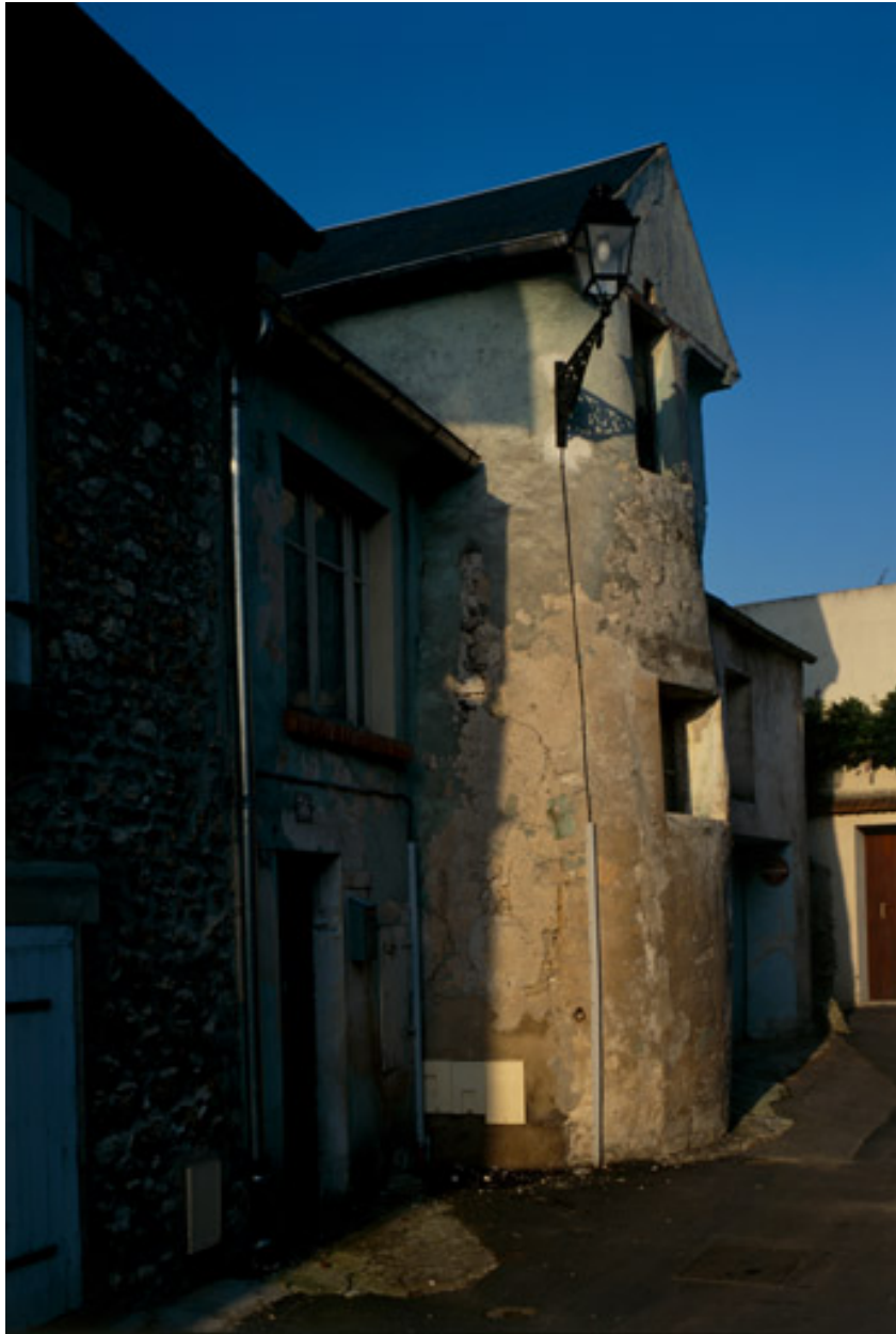
Tourelle d'escalier au 56, rue du Village Saint-Martin.
