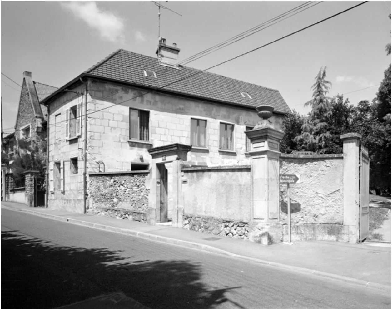
Ancien bureau d'octroi, 19bis rue Jules-Maciet. Vue de situation depuis la rue.
