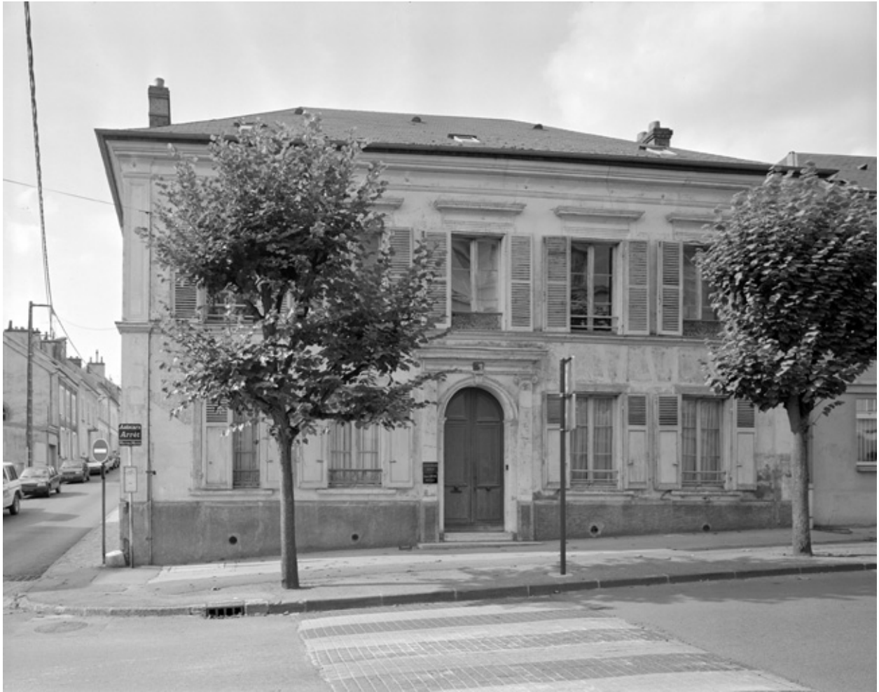
Maison, 32 avenue de Soissons.
