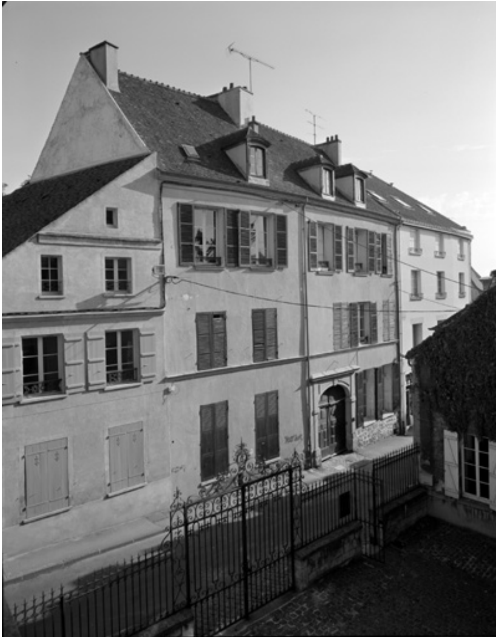
Hôtel, 9 rue Jean-de-La Fontaine. Vue des façades sur rue.
