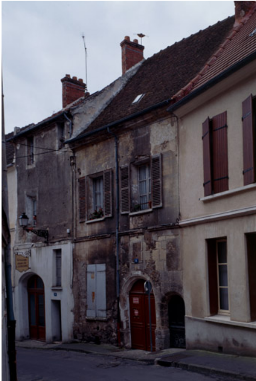
Maison, 6 rue Jean-de-la Fontaine. Vue depuis la rue.
