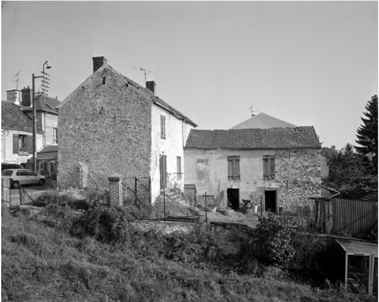
Ancienne ferme, 8 rue Charles-Martel.
