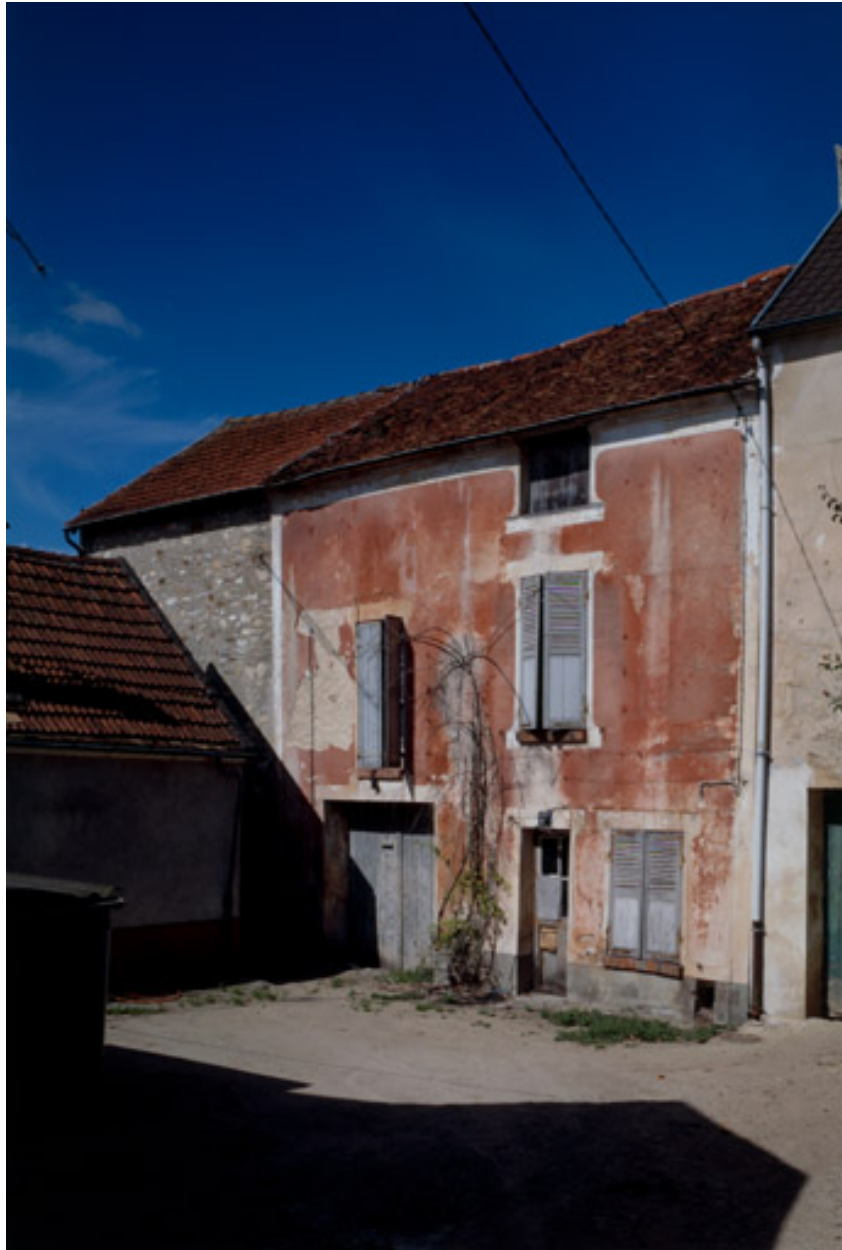
Ferme, 26 rue de Vincelles. Vue de la façade sur la cour commune.
