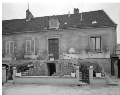
Maison, 41 rue Paul-Doucet. Vue de la façade principale sur cour. Phot. Thierry Lefébure IVR22_19950200336V
