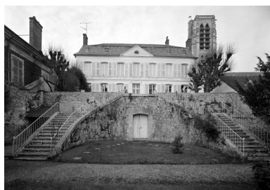
Hôtel, 28 rue Saint-Crépin. Façade sur le jardin. Phot. Thierry Lefébure IVR22_19930202066P
