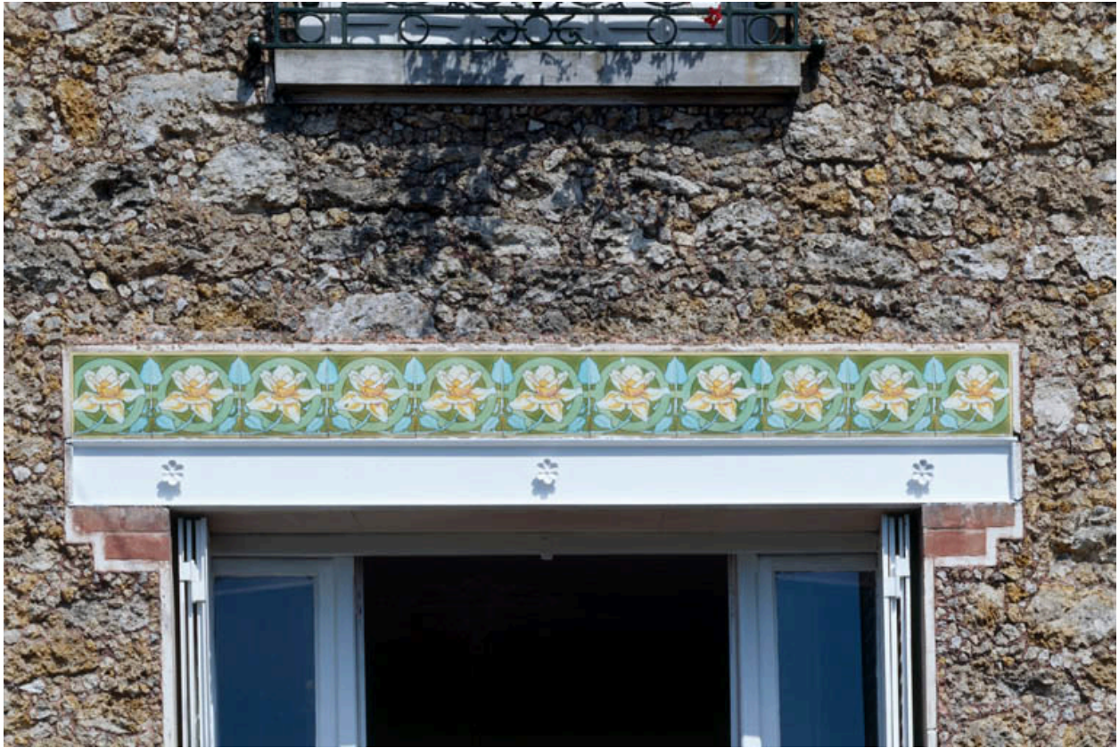
Bandeau en céramique surmontant un linteau de fenêtre, 66 rue de Fère.
