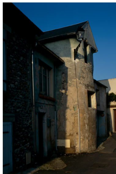
Tourelle d'escalier au 56, rue du Village Saint-Martin. Phot. Thierry Lefébure IVR22_19940201039XA
