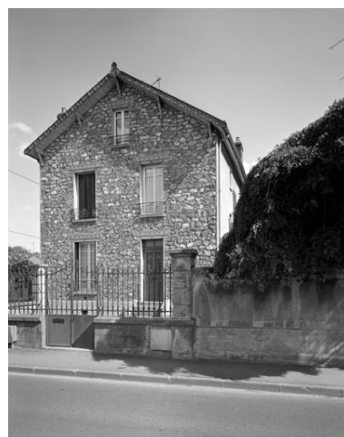
Maison, 20 avenue d'Essômes. Vue depuis la rue. Phot. Thierry Lefébure IVR22_19930200926V
