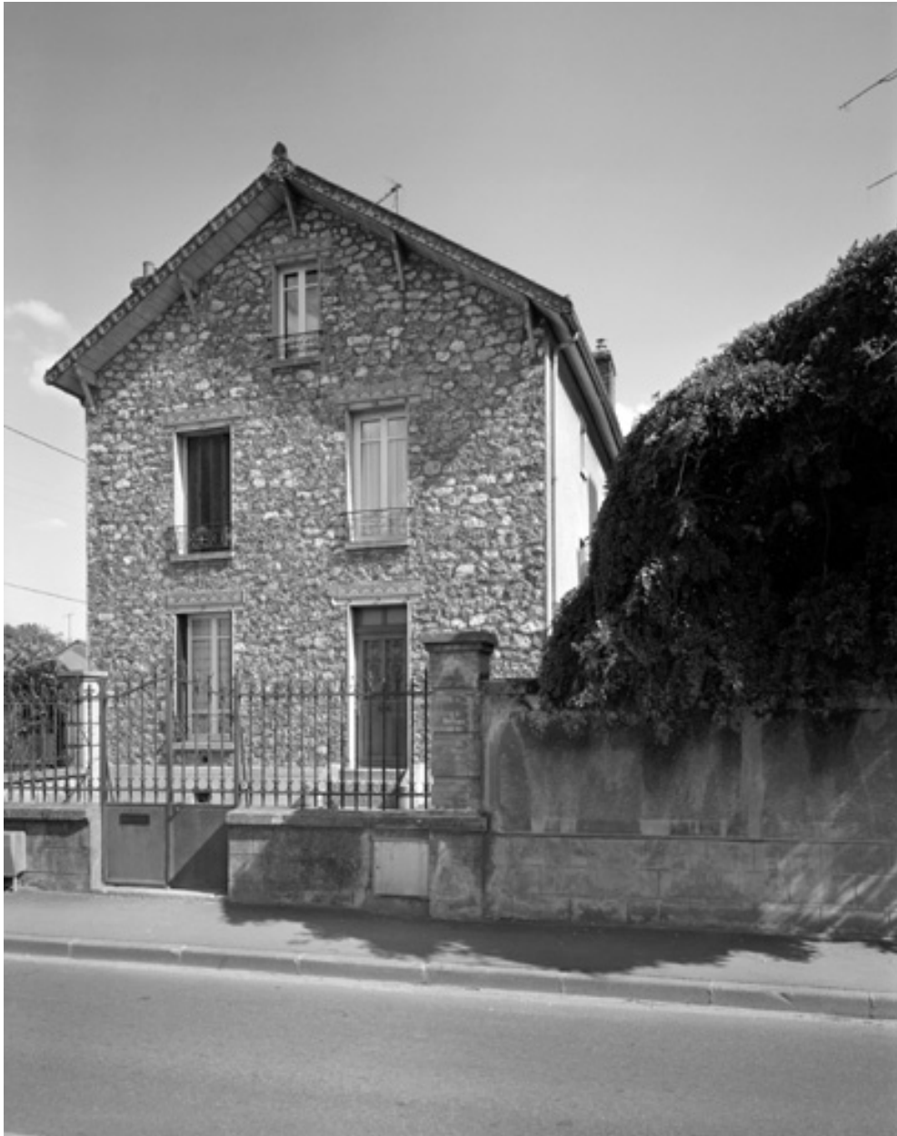
Maison, 20 avenue d'Essômes. Vue depuis la rue.
