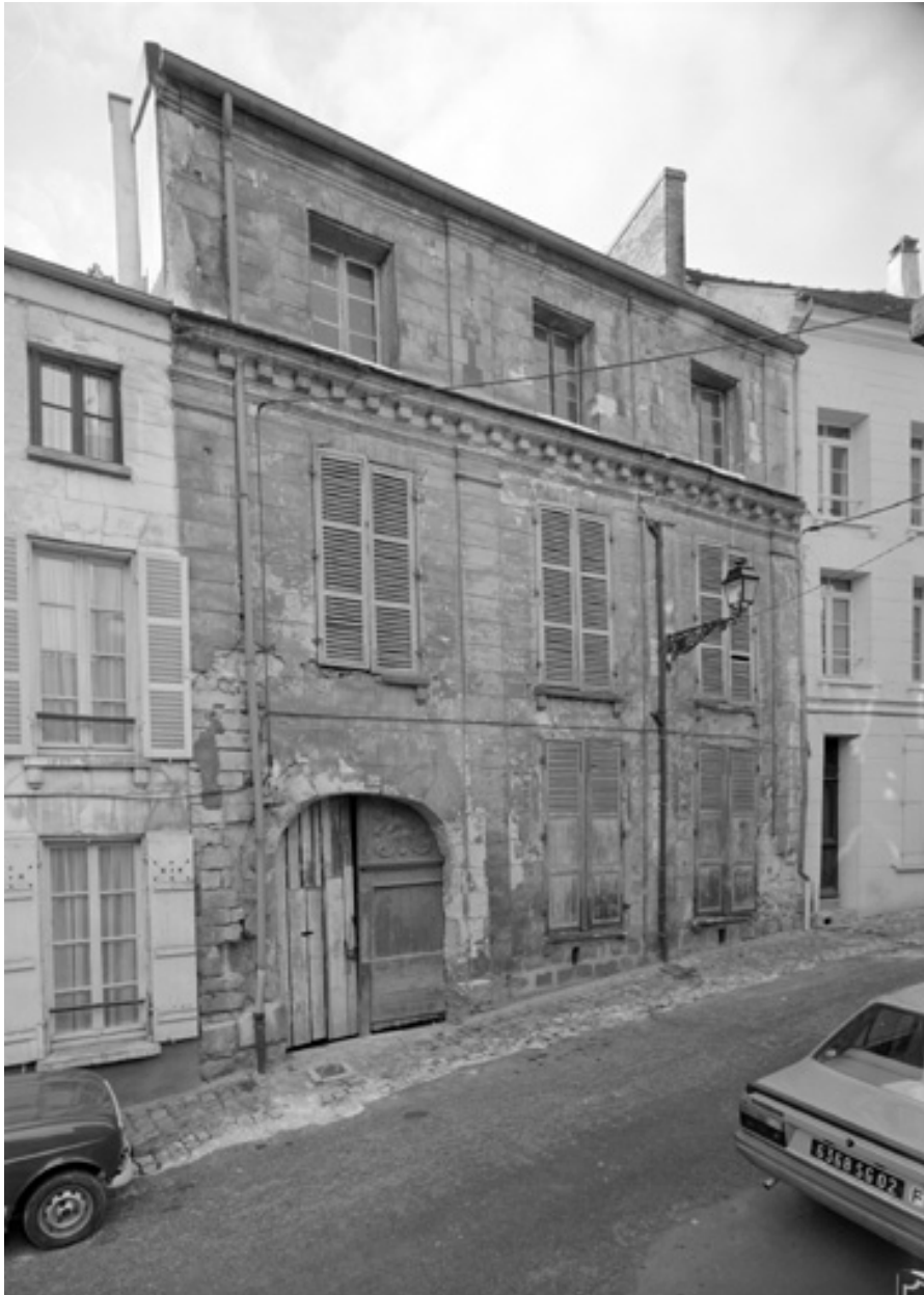
Hôtel, 32 rue du Château. Vue depuis la rue.
