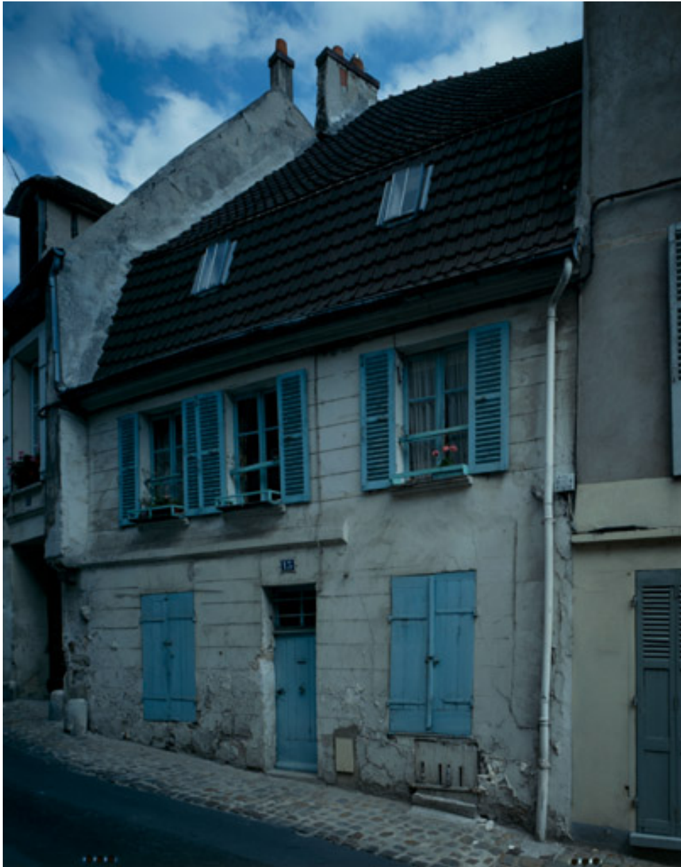
Maison, 15 rue du Château.
