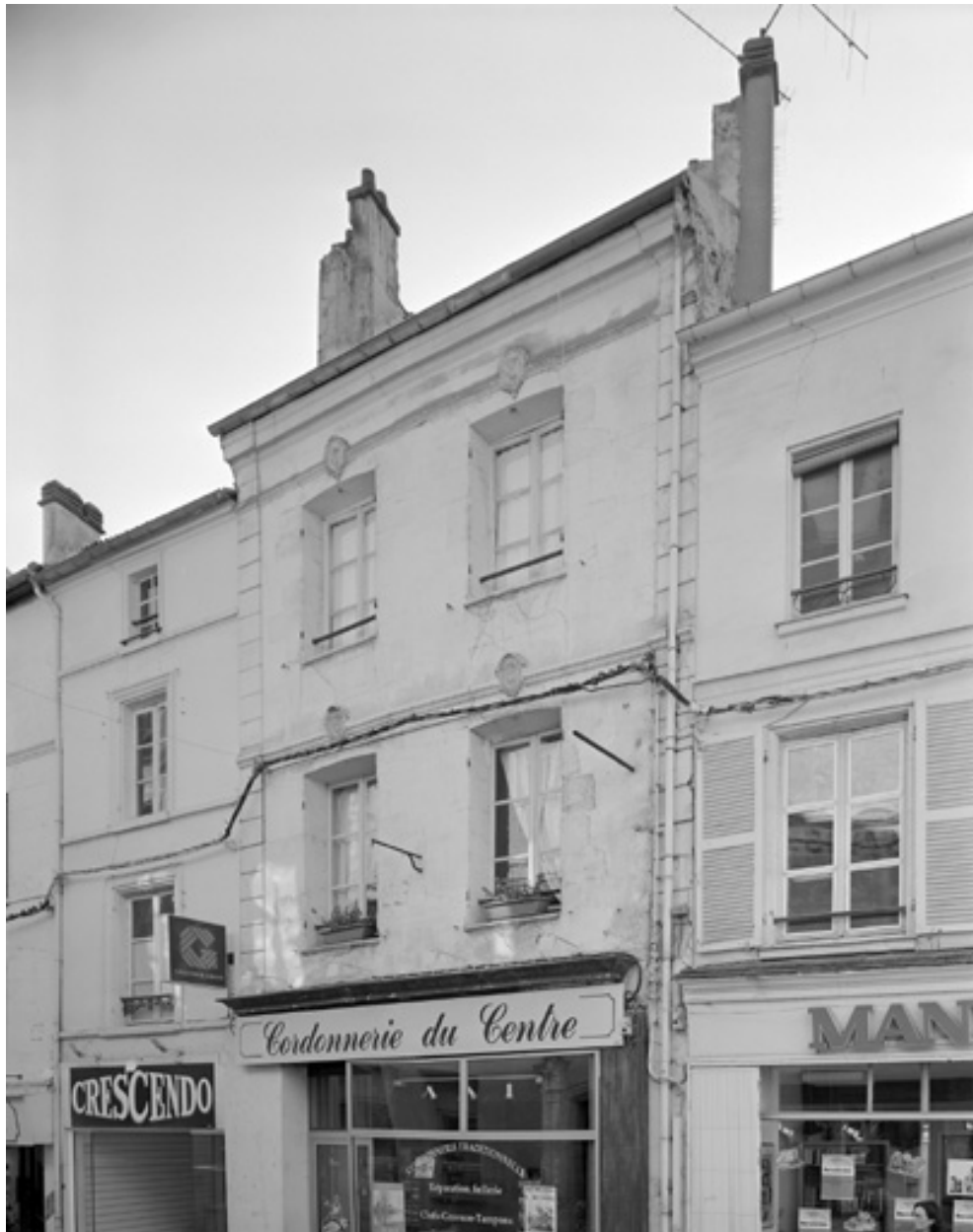
Maison, 68 Grande-rue. Élévation sur la rue.
