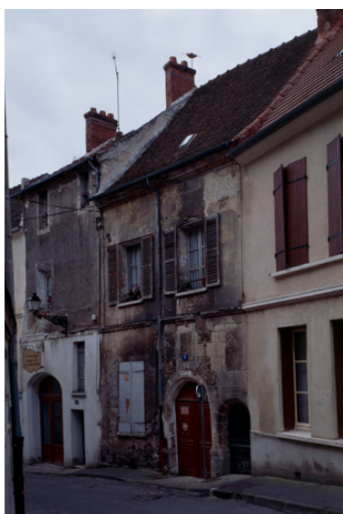
Maison, 6 rue Jean-de-la-Fontaine. Vue depuis la rue. Phot. Thierry Lefébure IVR22_19930201898XA
