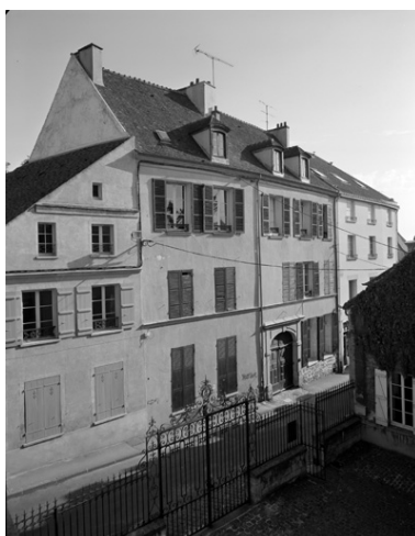
Hôtel, 9 rue Jean-de-La Fontaine. Vue des façades sur rue. Phot. Thierry Lefébure IVR22_19940201183V
