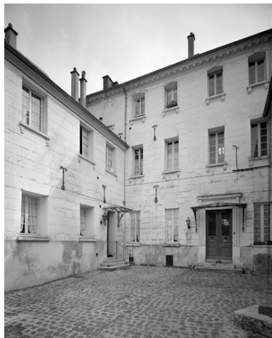
Hôtel, 72 Grande-rue. Vue des façades sur cour. Phot. Thierry Lefébure IVR22_19930200917V
