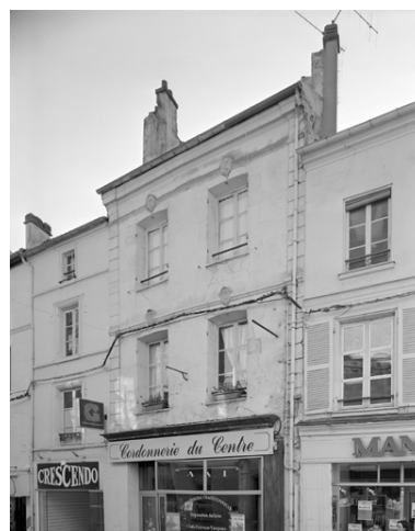
Maison, 68 Grande-rue. Elévation sur la rue. Phot. Thierry Lefébure IVR22_19930201920X
