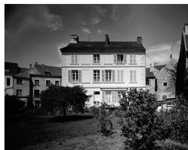
Hôtel, 72 Grande-rue. Vue de la façade sur le jardin. Phot. Thierry Lefébure IVR22_19930200918V
