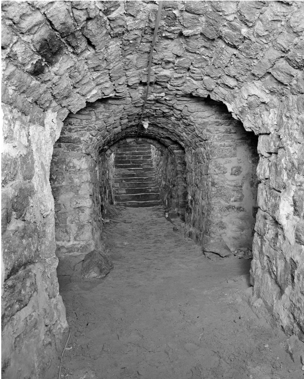
Cave d'un hôtel de la rue du Château.
