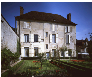
Hôtel, 12 rue Jean-de-La Fontaine. Façade sur le jardin. Phot. Thierry Lefébure IVR22_19930201412VA
