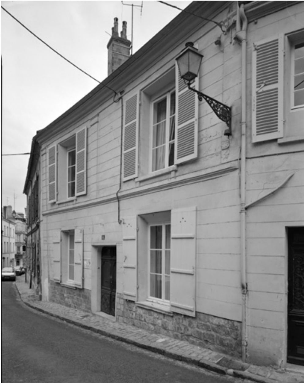
Maison, 16 rue du Château. Vue de la porte d'entrée et de la façade sur rue.
