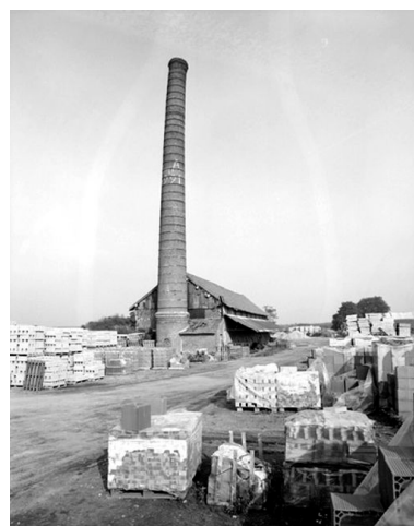
Four industriel et cheminée. Phot. Thierry Lefébure IVR22_19888000405X
