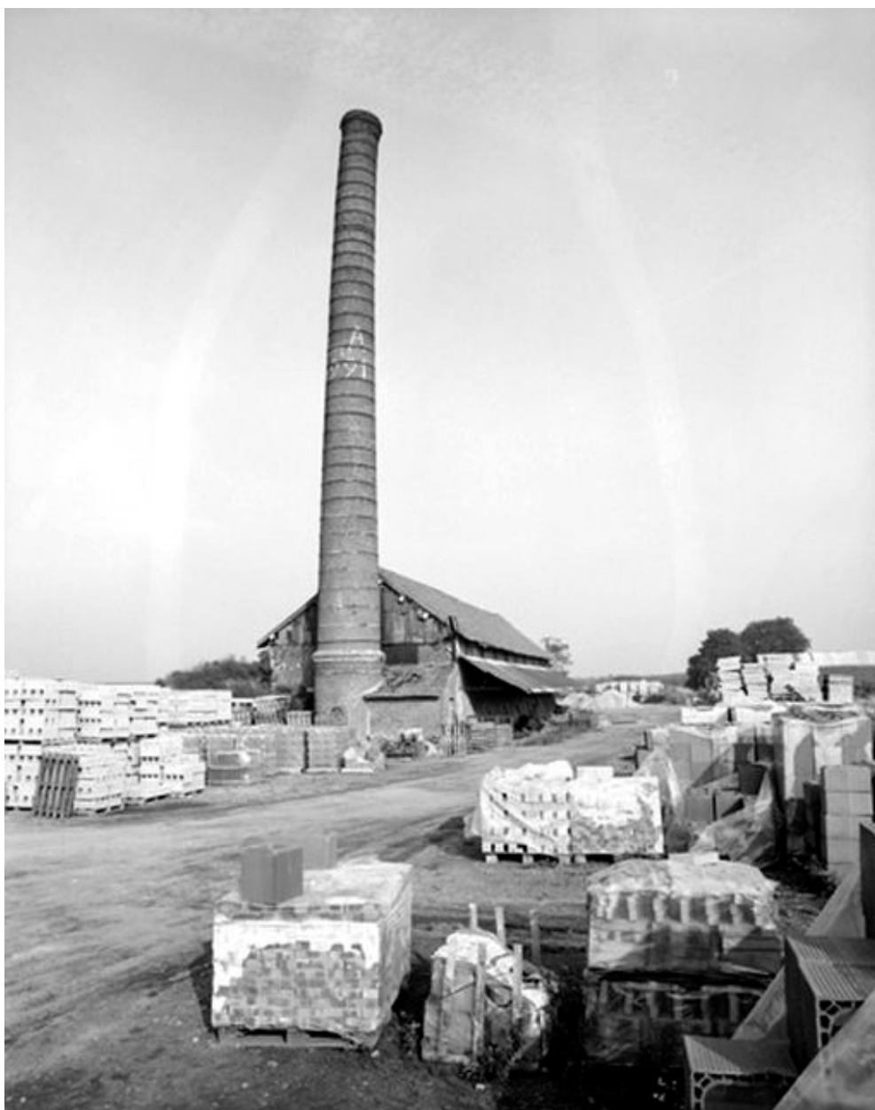
Four industriel et cheminée.
