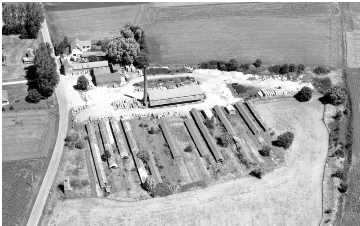
Vue aérienne, flanc sud.
