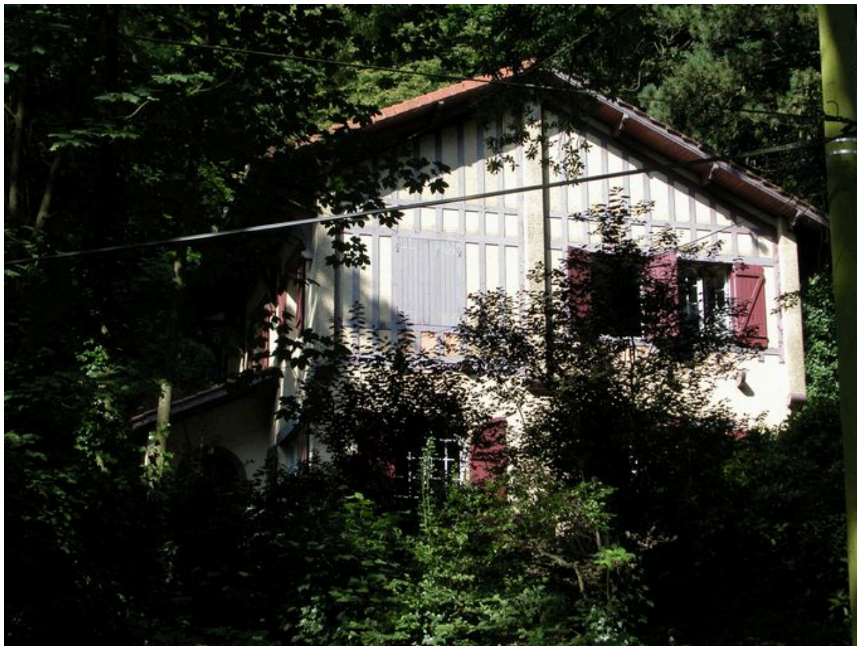
Vue d'ensemble depuis la rue.
