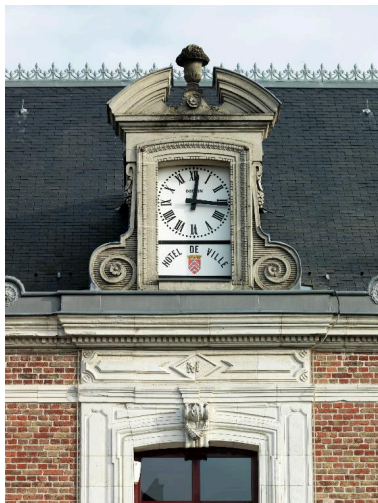
Façade sur rue, détail de la lucarne. Phot. Thierry Lefébure IVR22_20138000518NUC2A
