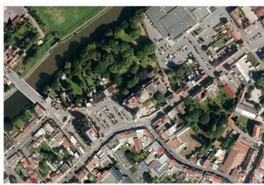
Photographie aérienne de 2018 présentant l'hôtel de ville (en A) et l'église Saint-Chrysole (en B). Repro. Jean-Marc Ramette IVR32_20215905028NUCA
