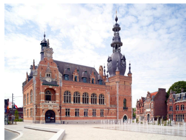
Vue générale depuis la Grand'Place, à l'est. Phot. Pierre Thibaut IVR32_20215900068NUCA
