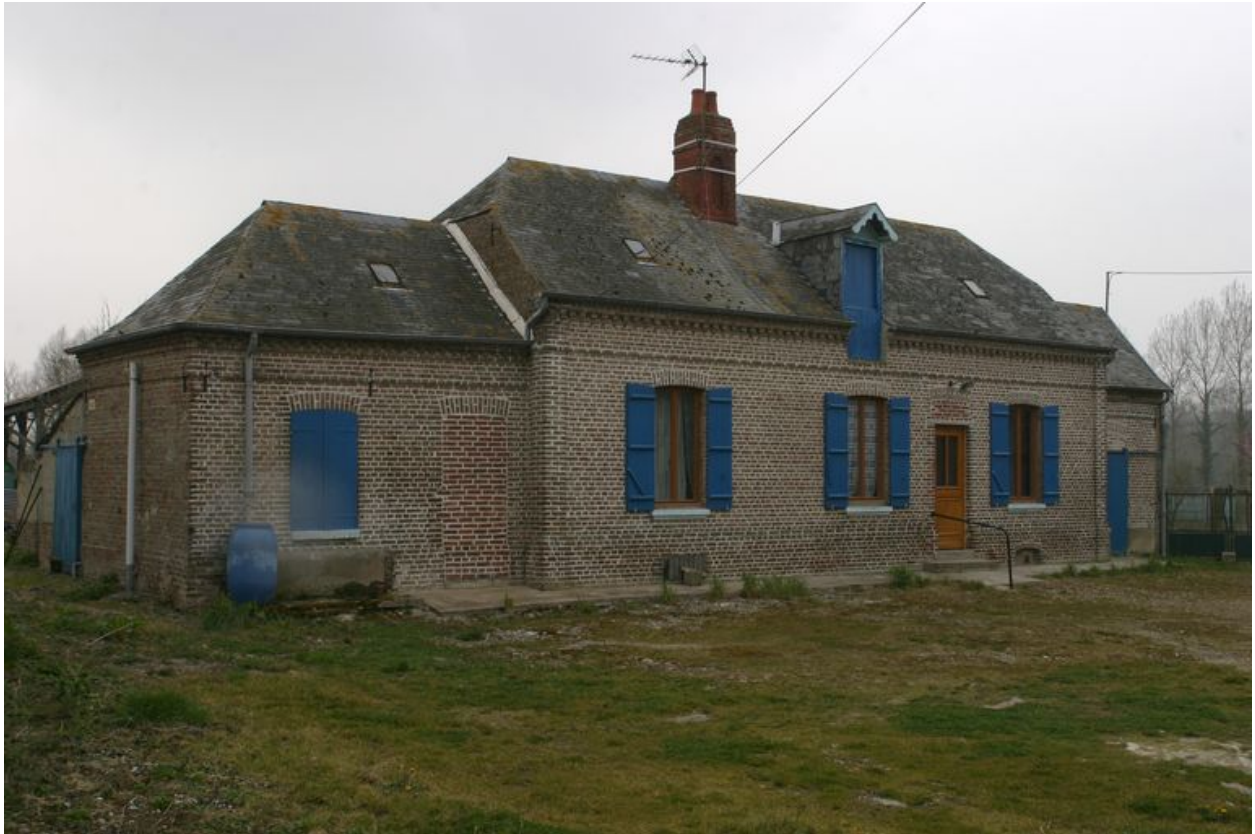
Vue du logis depuis la rue.
