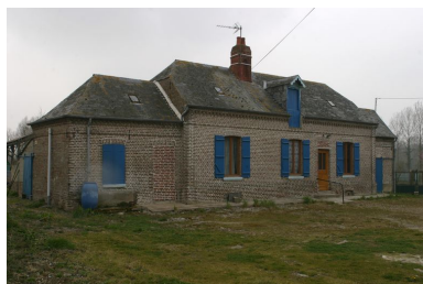
Vue du logis depuis la rue. Phot. Irwin Leullier IVR22_20078000198NUCA
