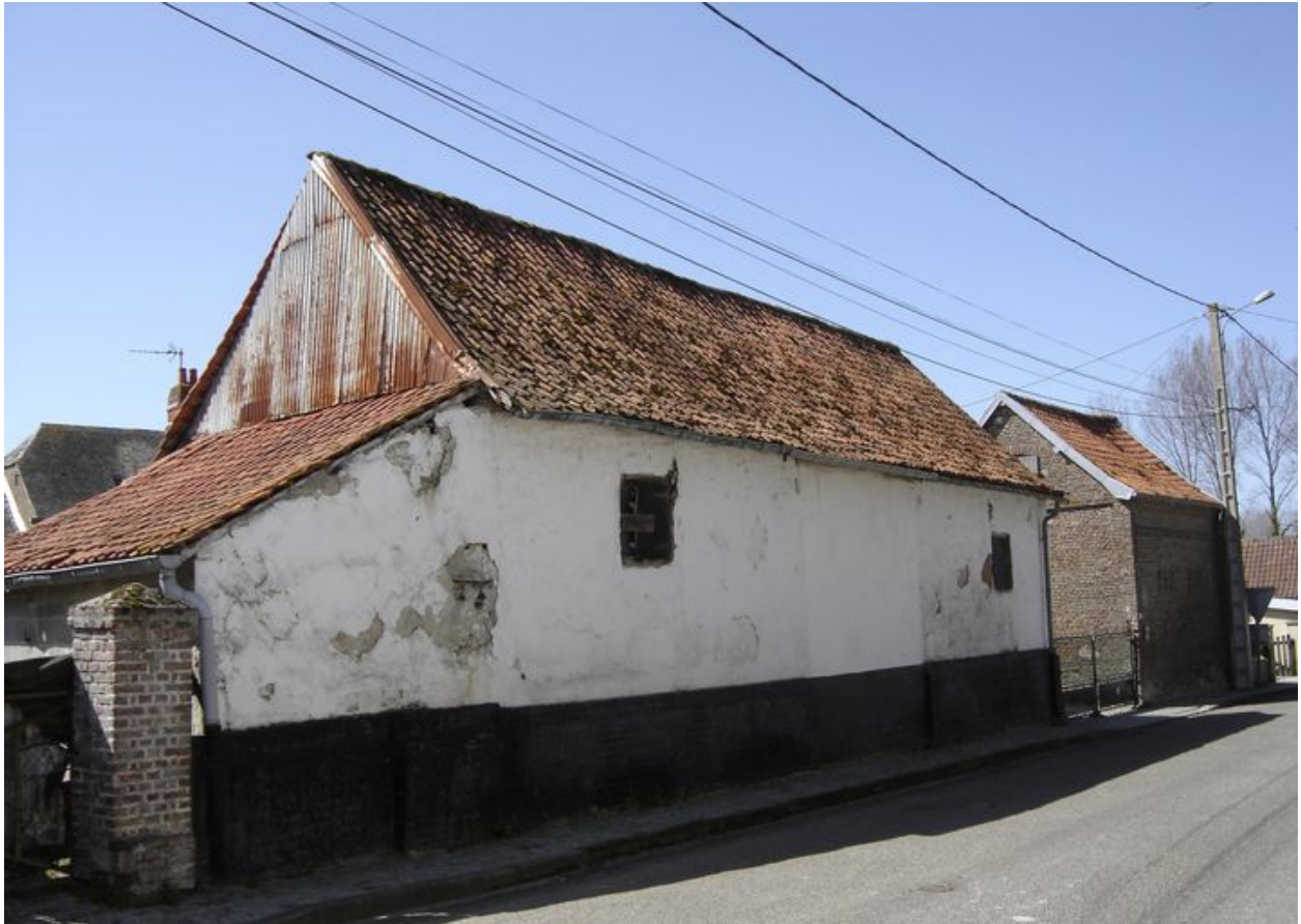
Vue des écuries en torchis depuis la rue.
