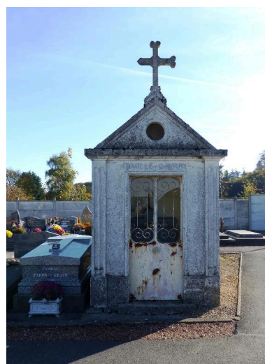
Tombeau (chapelle) de la famille Savary, maçons établis à Chaulnes autour de 1900. Phot. Isabelle Barbedor IVR32_20168006268NUCA
