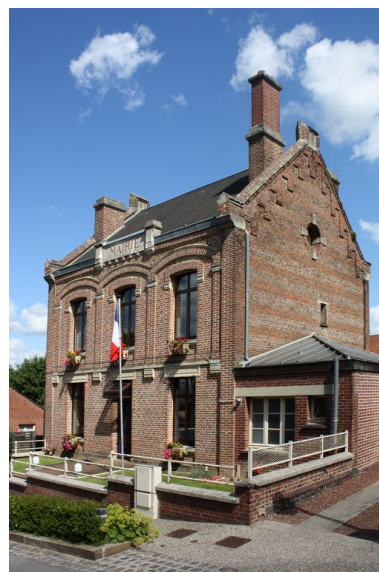
Vue d'ensemble. Phot. Bertrand Fournier IVR22_20088015427NUCA
