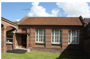
Ancienne école des garçons. Phot. Bertrand Fournier IVR22_20088015429NUCA
