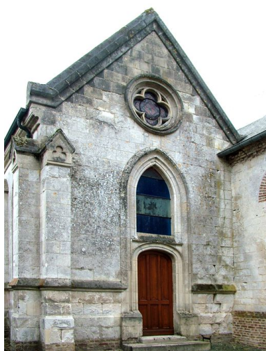
Façade de la chapelle. Phot. Frédéric Fournis IVR22_20118001154NUCA
