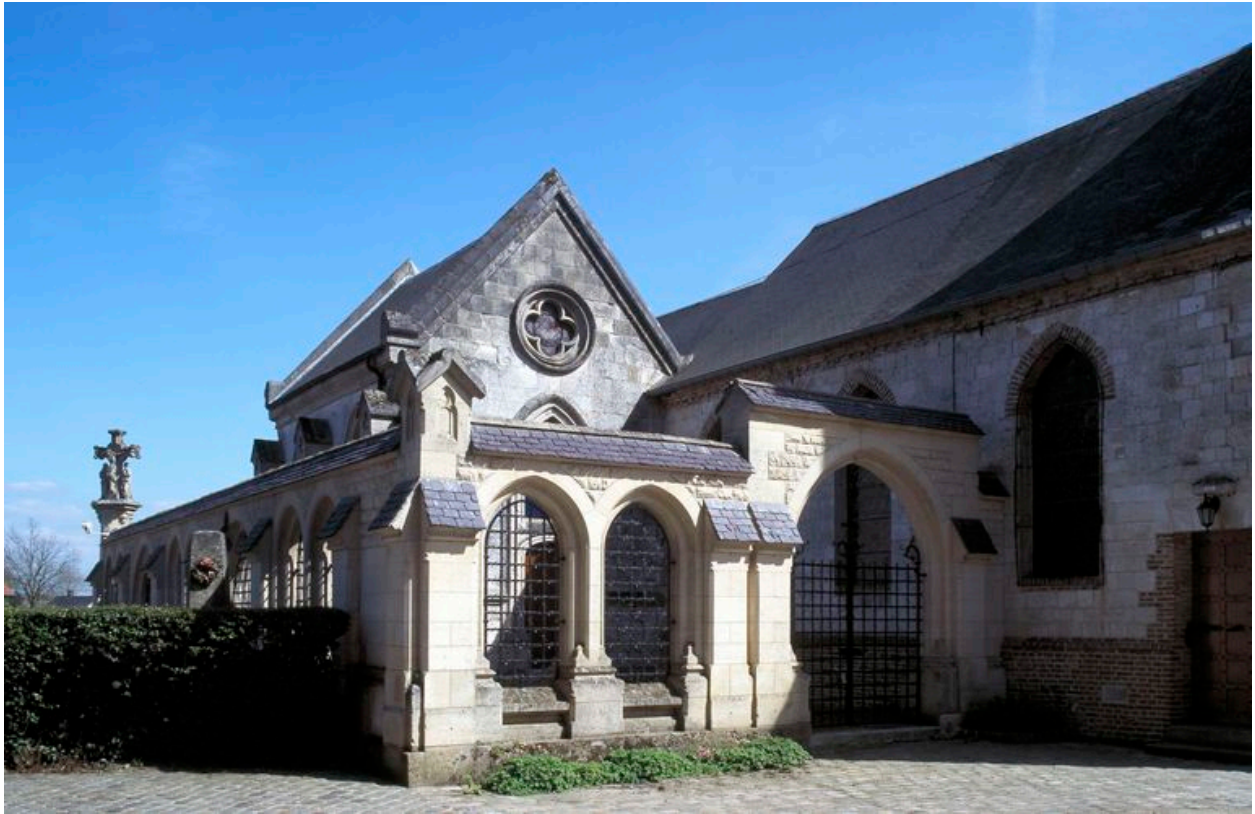
Vue générale de l'enclos et de la chapelle funéraire.
