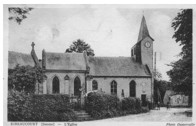
Vue de l'église et de la chapelle funéraire depuis le nord, années 1930 (coll. part.). Phot. Monnehay-Vulliet Marie-Laure IVR22_20118000155NUCA
