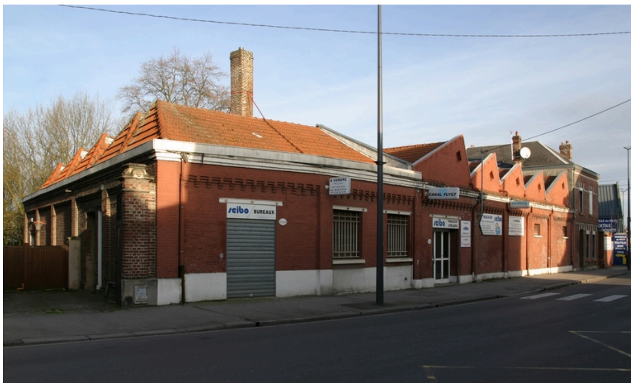
Façade antérieure des ateliers.
