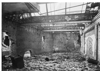
Vue intérieure du magasin industriel, par L. Maréchal, 1918-1919 (AD Aisne). Phot. Pillet Frédéric IVR22_20060205744NUCAB
