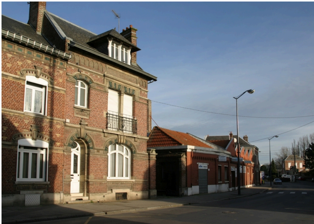
Vue générale de l'usine et du logement patronal.
