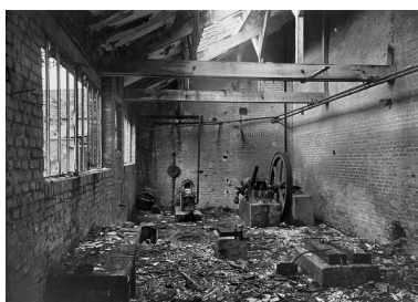
Vue intérieure de la salle des machines, par L. Maréchal, 1918-1919 (AD Aisne). Phot. Pillet Frédéric IVR22_20060205745NUCAB
