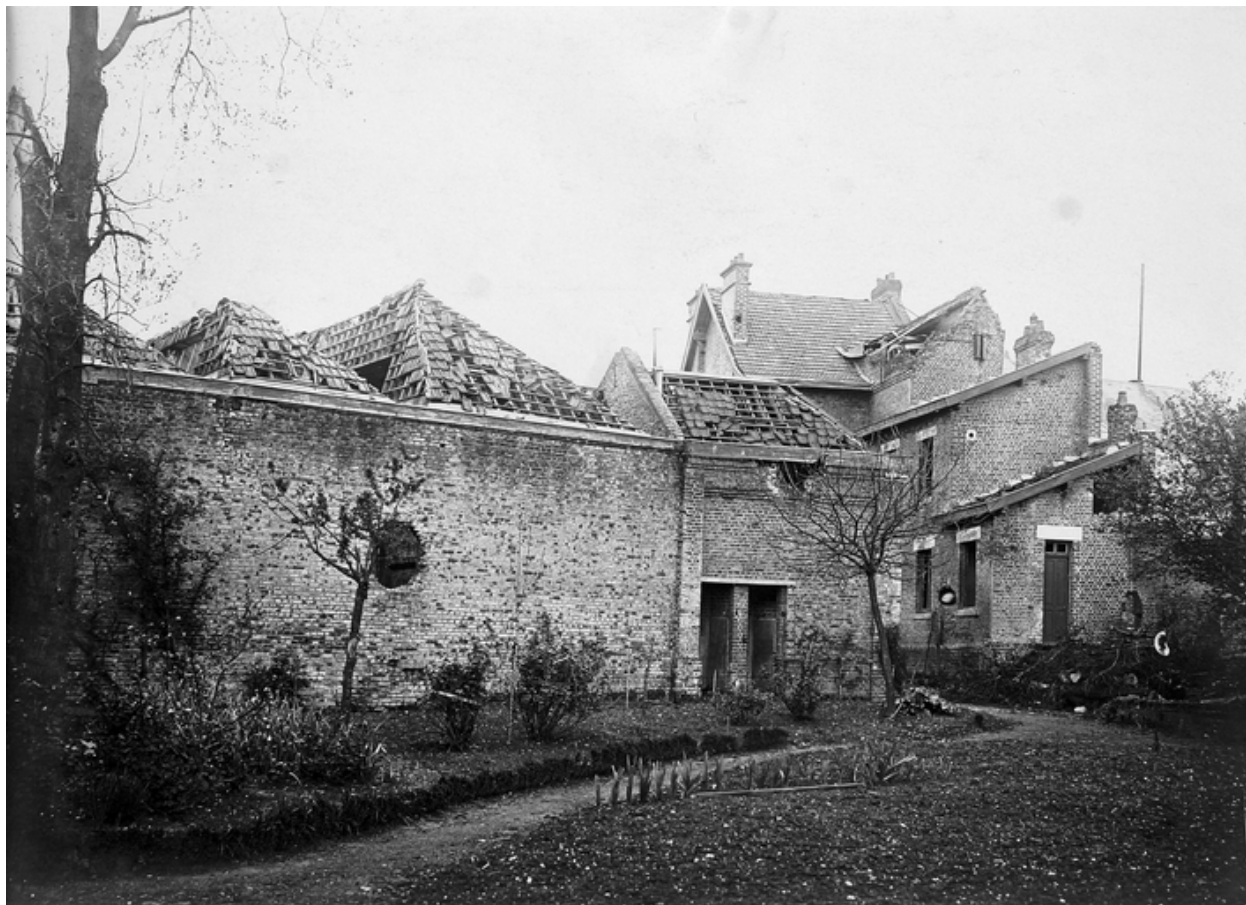
Façade sur cour des ateliers et du magasin industriel, par L. Maréchal, 1918-1919 (AD Aisne).
