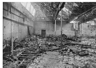
Vue intérieure des ateliers, par L. Maréchal, vers 1918-1919 (AD Aisne). Phot. Pillet Frédéric IVR22_20060205743NUCAB
