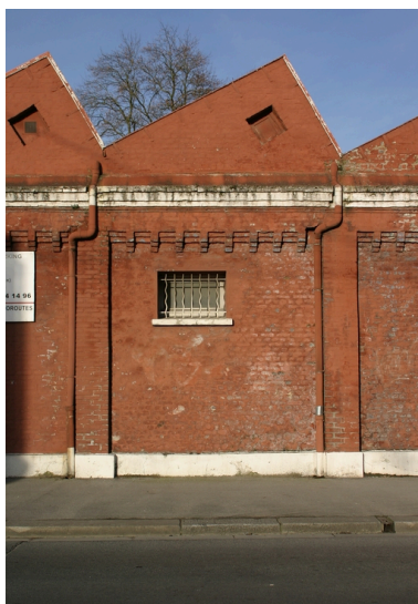
Une travée des ateliers. Phot. Frédéric Pillet IVR22_20070205199NUCA
