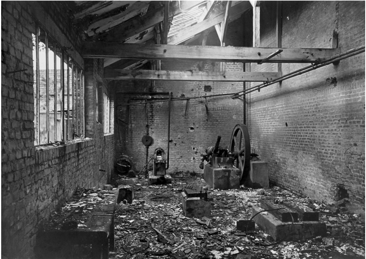
Vue intérieure de la salle des machines, par L. Maréchal, 1918-1919 (AD Aisne).
