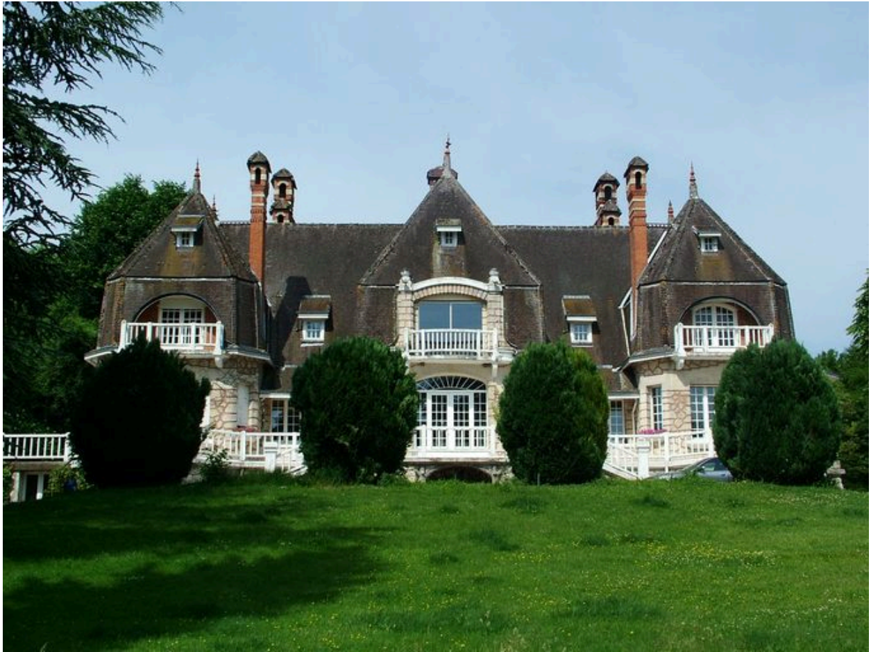
Vue générale du château de Craonnelle.
