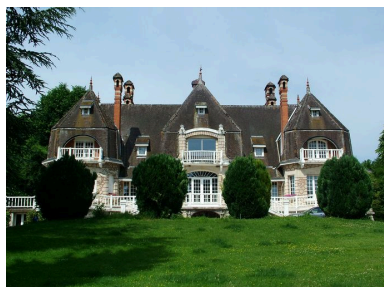
Vue générale du château de Craonnelle.
