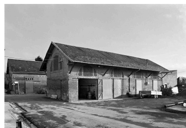
Vue d'un bâtiment de l'abattoir élevé par Gustave-Eugène Dupont entre 1898 et 1901. Phot. Pierre-Yves Brest IVR22_19990207329Z
