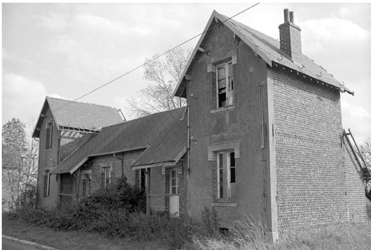
Logement d'ouvriers, vue générale, élévation antérieure.
