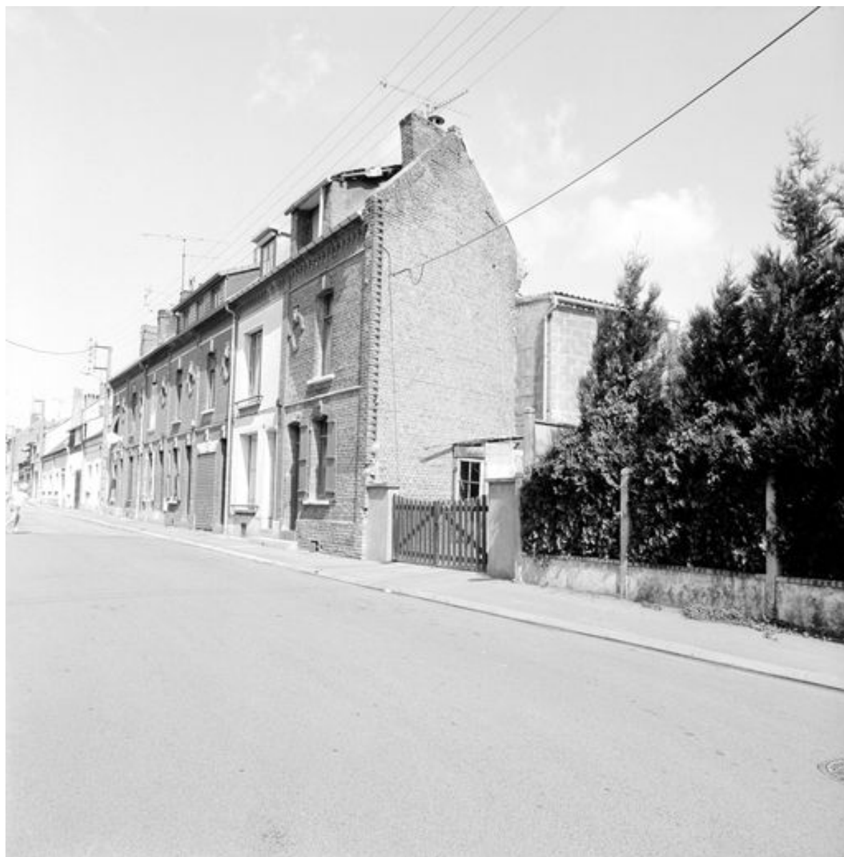
Logements d'ouvriers acquis par Ernest Cauvin.
