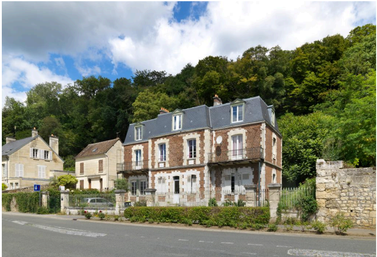
Villa Les Trois Marches. Vue sud-est.
