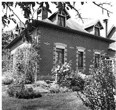
Elévation postérieure du logis de 1927. Phot. Thierry Lefébure IVR22_20020200470X
