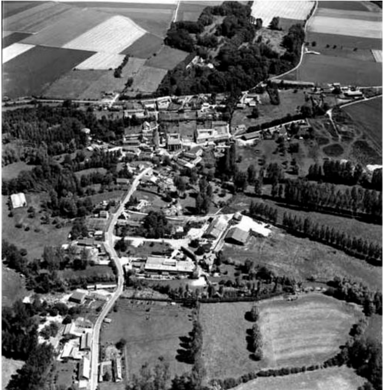
Vue aérienne, flanc sud-ouest.
