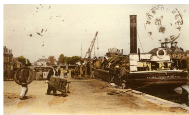
Le port du Canal de Saint-Quentin vers 1900 : à droite, les toitures de la malterie (BM Saint-Quentin). Phot. Pillet Frédéric IVR22_20050206246NUCAB
