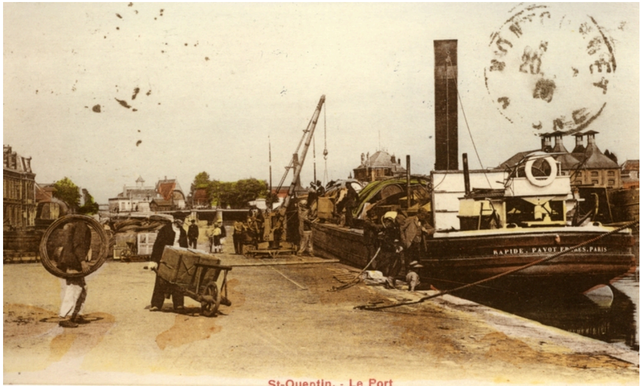
Le port du Canal de Saint-Quentin vers 1900 : à droite, les toitures de la malterie (BM Saint-Quentin).
