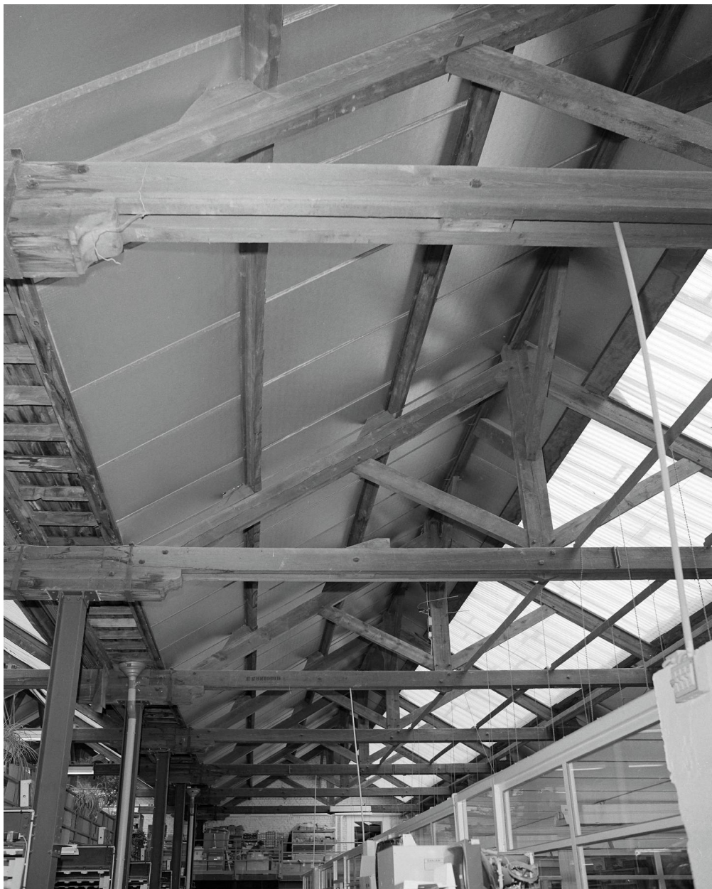
Atelier de fabrication. Vue de la charpente.
