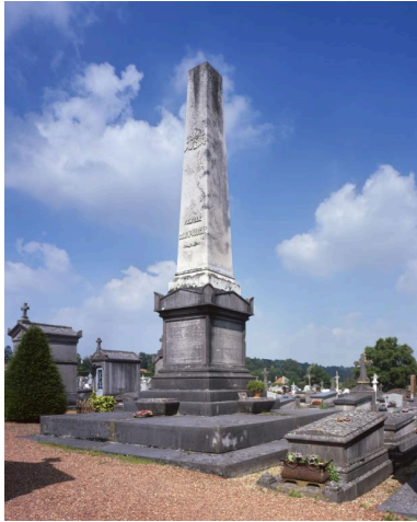
Vue du tombeau. Phot. Franck Bürjes IVR22_19990203214VA
