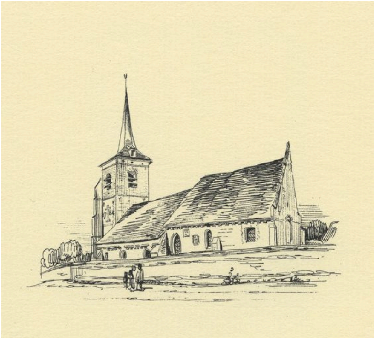
Vue générale de l'ancienne église par Louis Duthoit, avant 1848 (In : Aimé et Louis Duthoit..., 1979).
