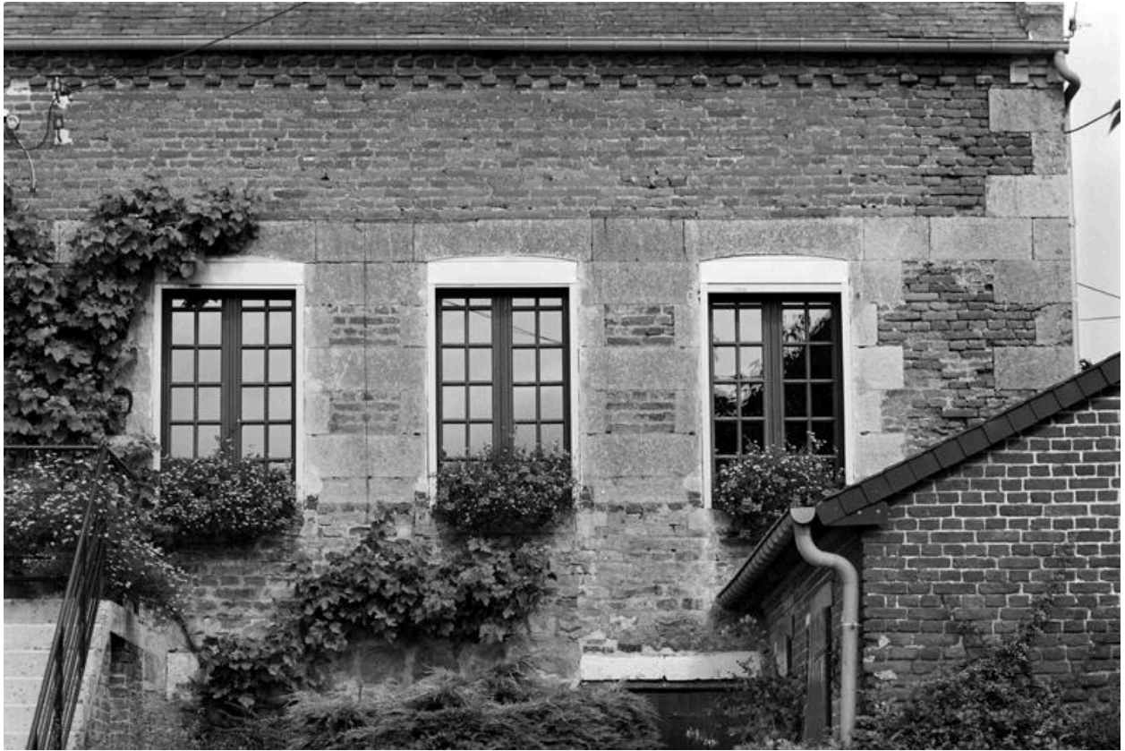
Détail des encadrements de baies en pierre bleue du logis (daté de 1804).
