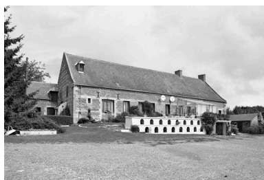
Vue de la façade sur cour du logis (daté de 1804). Phot. Pierre-Yves Brest IVR22_19990204397Z
