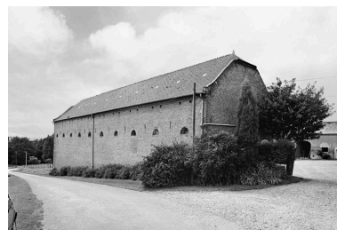
Vue de l'écurie. Phot. Pierre-Yves Brest IVR22_19990204480Z
