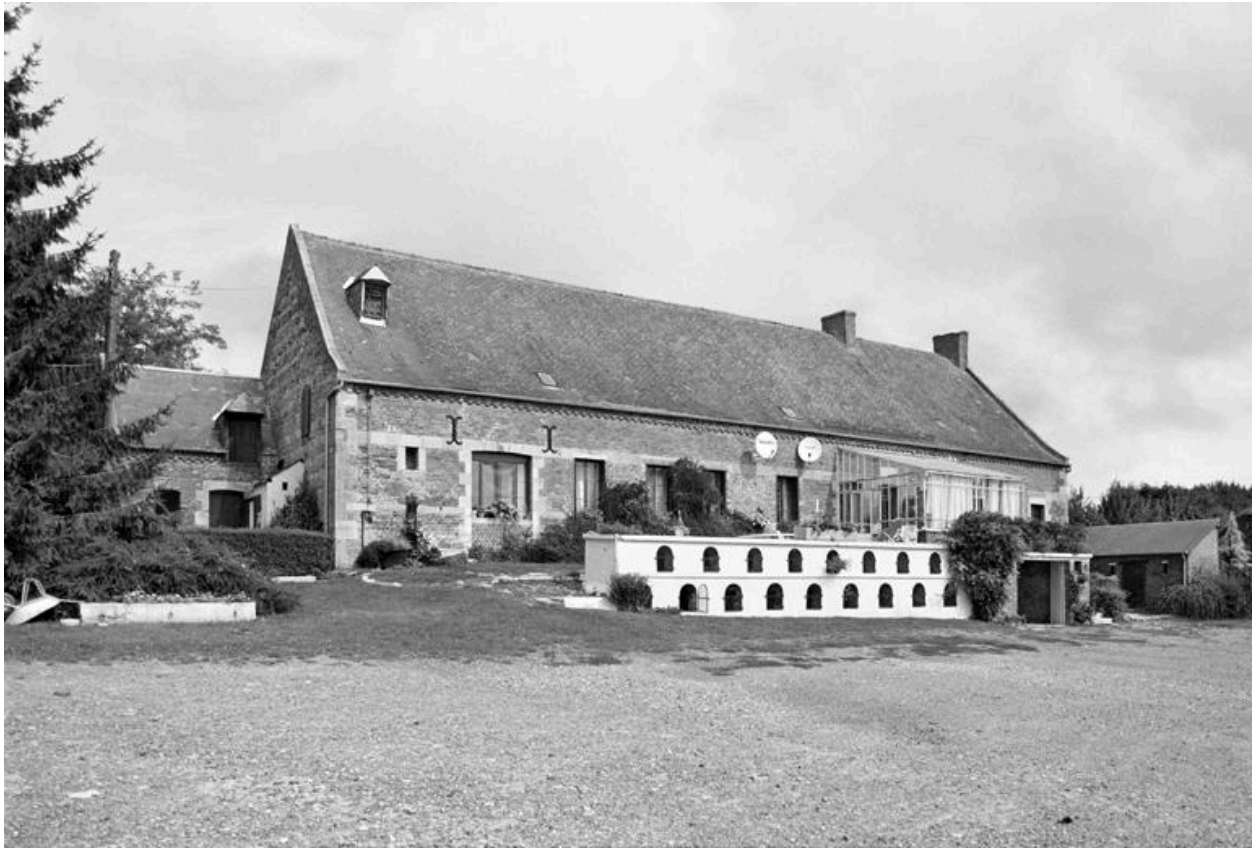
Vue de la façade sur cour du logis (daté de 1804).
