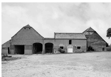
Vue des bâtiments de ferme. Phot. Pierre-Yves Brest IVR22_19990204399Z
