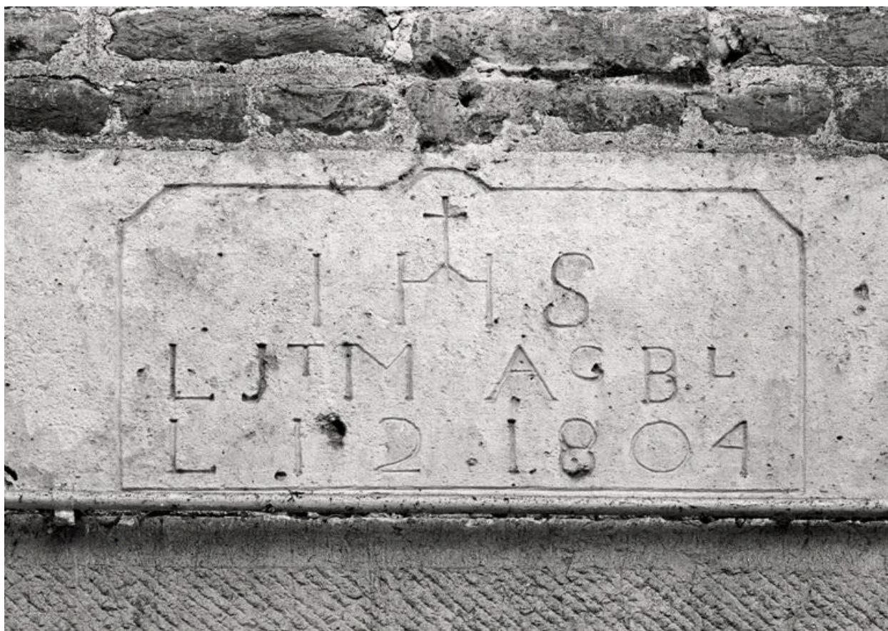
Détail de l'inscription portée au-dessus du linteau de la porte du logis.
