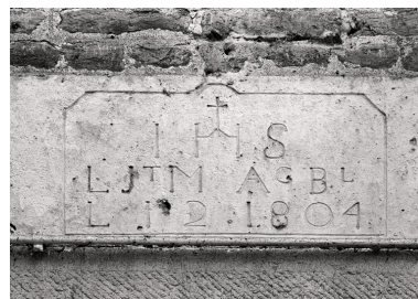
Détail de l'inscription portée au- dessus du linteau de la porte du logis. Phot. Pierre-Yves Brest IVR22_19990204395Z
