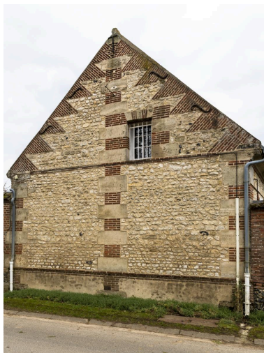
Pignon de logis en brique et pierre avec couteaux picards, n°2 de Boursines, vue depuis le nord.
