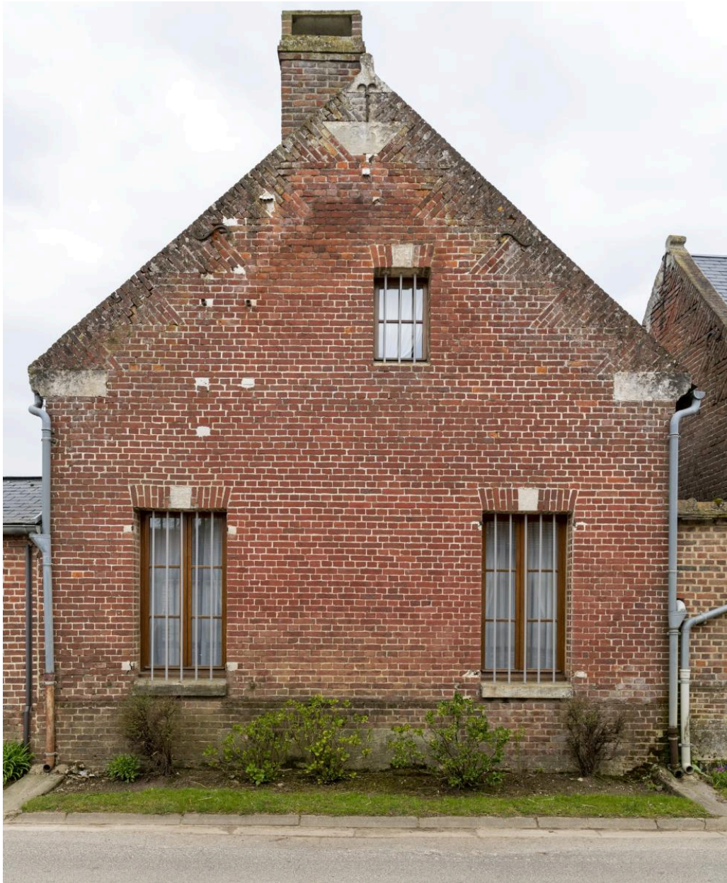
Pignon de logis sur rue avec couteaux picards, n°4 rue de Boursines, vue depuis le nord.
