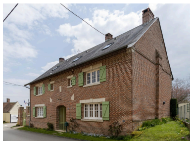
Ancienne grange reconverte en logis, n°44 rue de Boursines, vue depuis le nord-ouest. Phot. Marc Kérignard IVR32_20216000302NUCA
