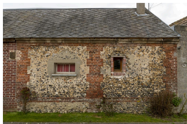
Bâtiment en brique et moellon de silex, n°13 rue du Byon, vue depuis le nord-ouest.
