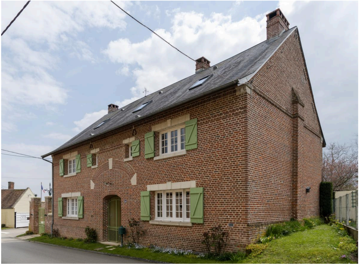
Ancienne grange reconvertie en logis, n°44 rue de Boursines, vue depuis le nord-ouest.
