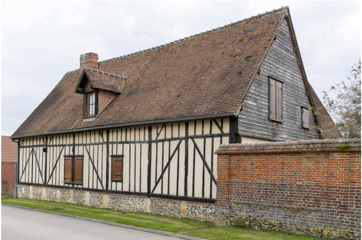
Logis sur rue, n°26 rue de Boursines, vue depuis le nord-ouest.
