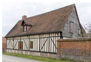
Logis sur rue, n°26 rue de Boursines, vue depuis le nord-ouest. Phot. Marc Kérignard IVR32_20216000300NUCA
