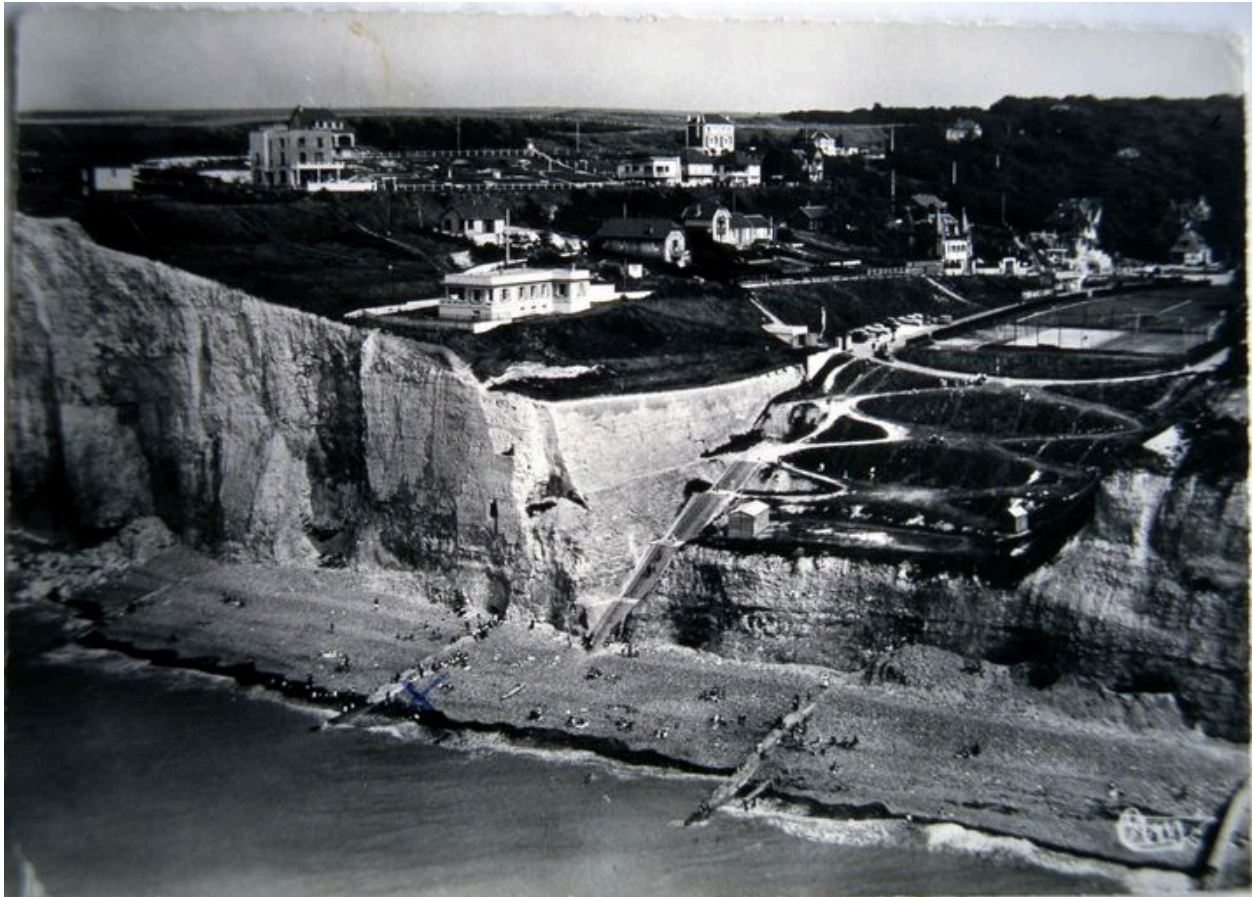
Les Hublots en cours de construction, carte postale, 3e quart 20e siècle (coll. part.).
