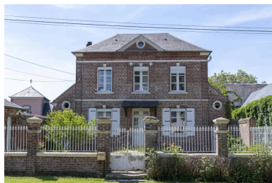
Ancien presbytère, n°1 rue Gaillard, vue de la façade depuis la rue. Phot. Marc Kérignard IVR32_20216000598NUCA
