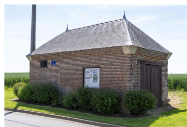
Remise des pompes à incendie, construite entre 1855 et 1870, rue de la Ville, vue depuis le nord-ouest. Phot. Marc Kérignard IVR32_20216000601NUCA
