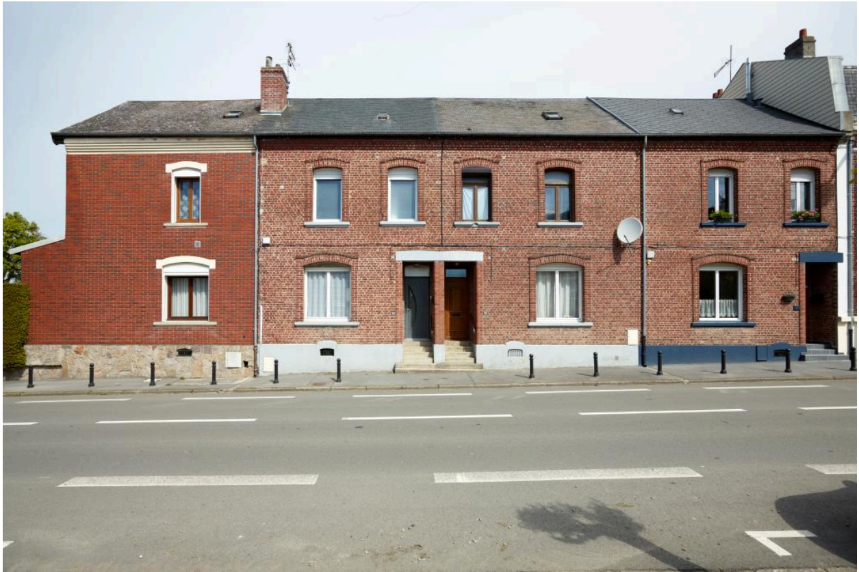
vue de la façade principale depuis la rue de la République.
