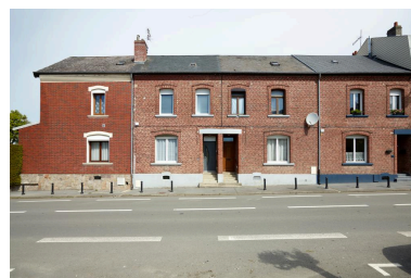
vue de la façade principale depuis la rue de la République. Phot. Delphine Volto-Jourdan IVR32_20216200567NUCA
