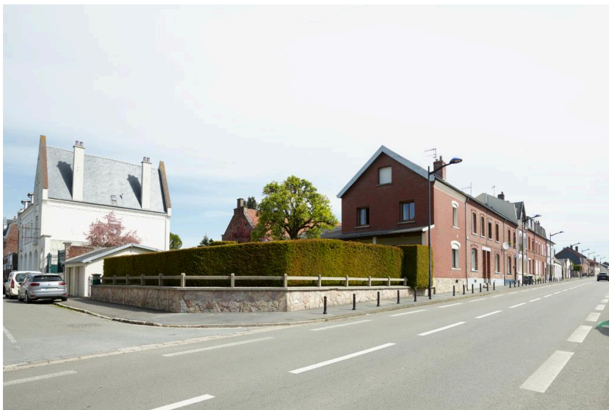
Vue de mise en situation depuis l'angle des rues Gambetta et de la République.
