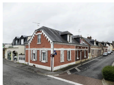
Vue d'ensemble de la cité Maguin. Phot. Thierry Lefébure IVR32_20160200104NUC2A
