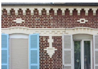
Détail du cordon et des éléments décoratifs de la façade sur rue. Phot. Bertrand Fournier
