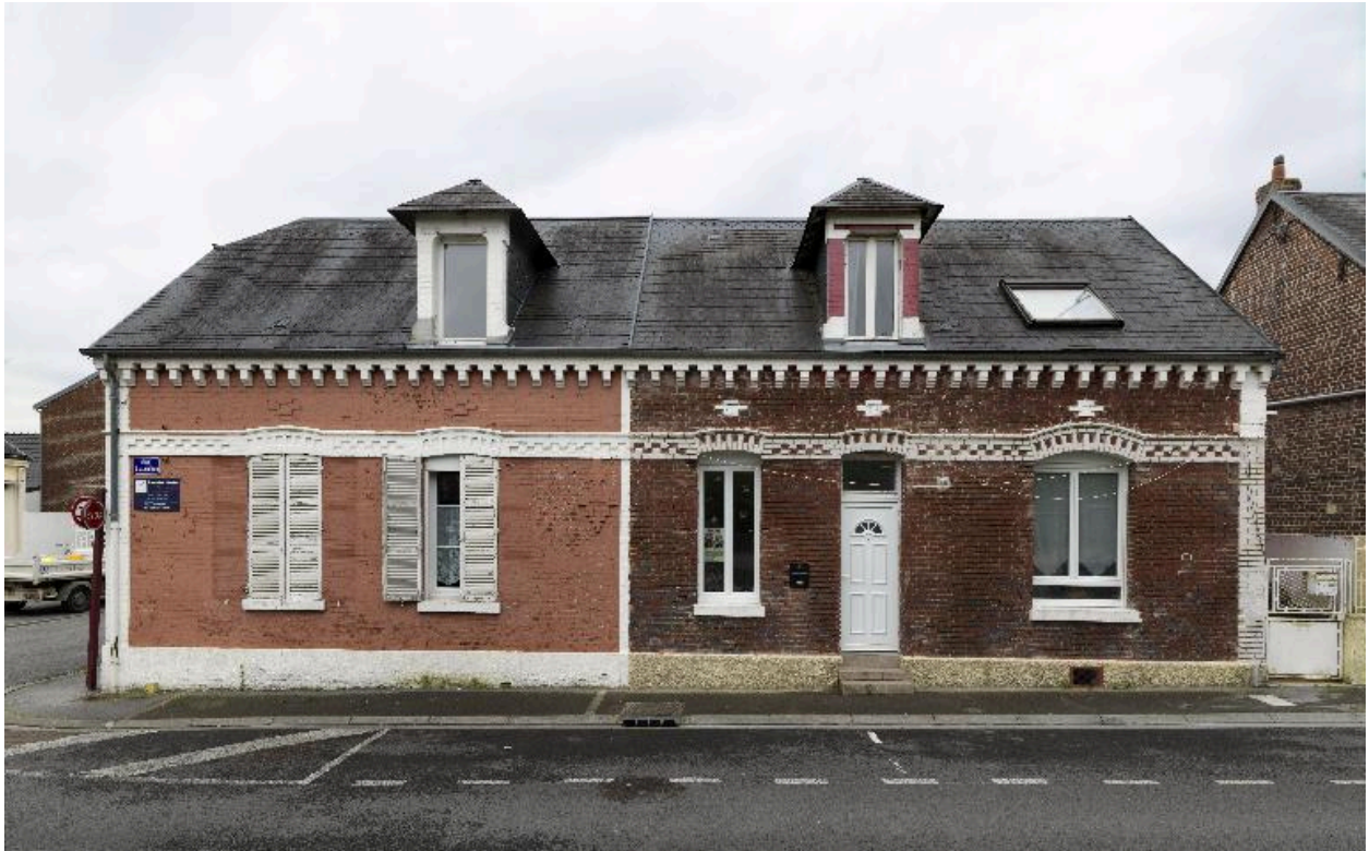
Façade sur rue des deux premières maisons de la cité Maguin, dont celle située à l'angle de la rue Aristide-Briand.
