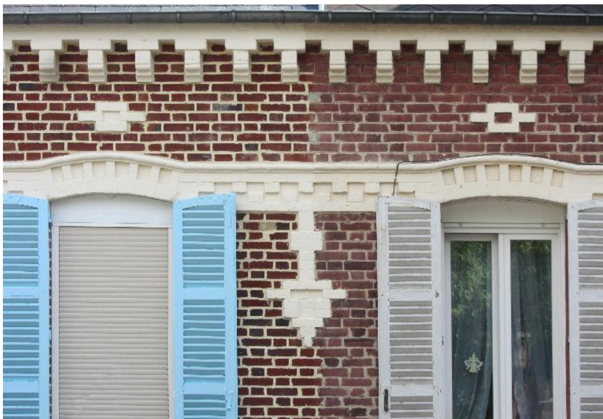
Détail du cordon et des éléments décoratifs de la façade sur rue.
