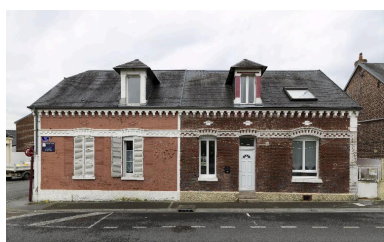
Façade sur rue des deux premières maisons de la cité Maguin, dont celle située à l'angle de la rue Aristide-Briand.
