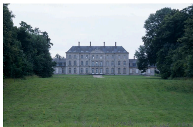
La façade ouest du château. Phot. Irwin Leullier IVR22_19998001592ZA
