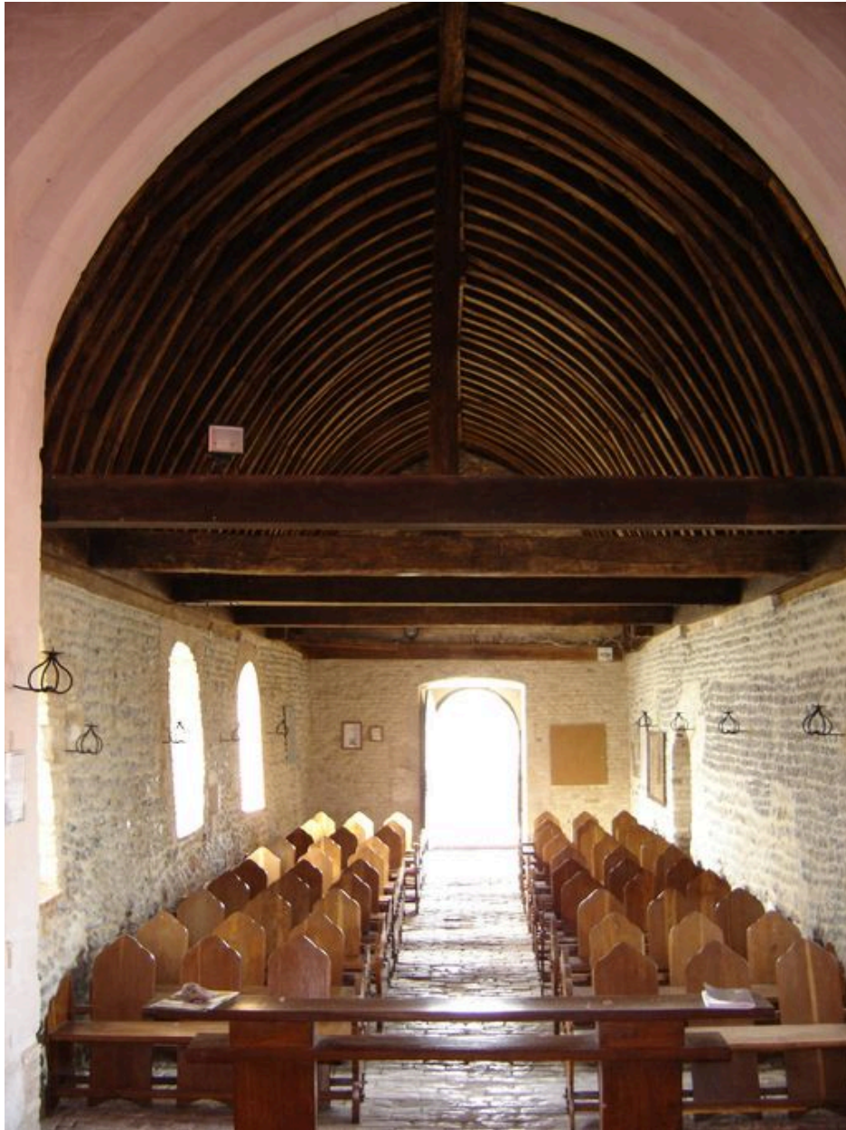
Vue intérieure de la nef depuis l'est.
