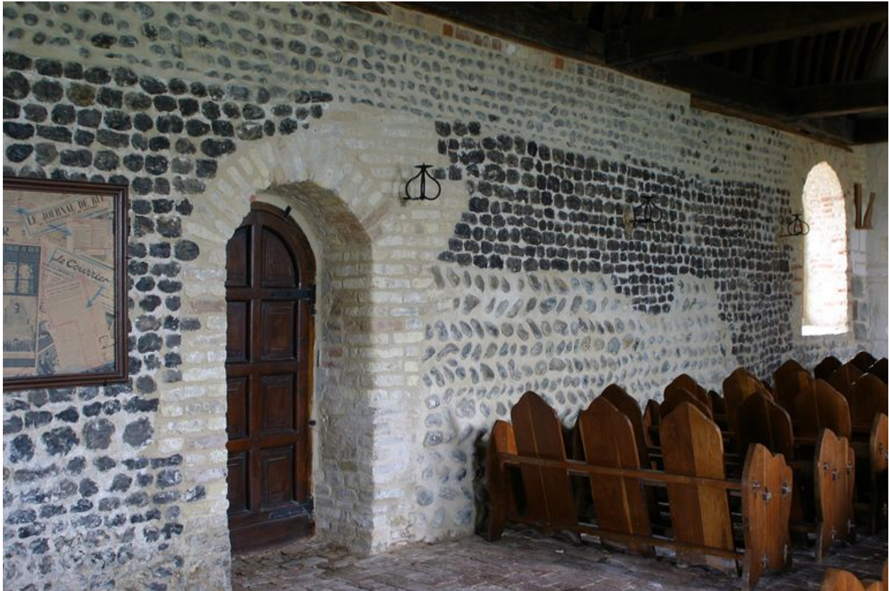
Vue détaillée de la maçonnerie mixte du mur intérieur nord.
