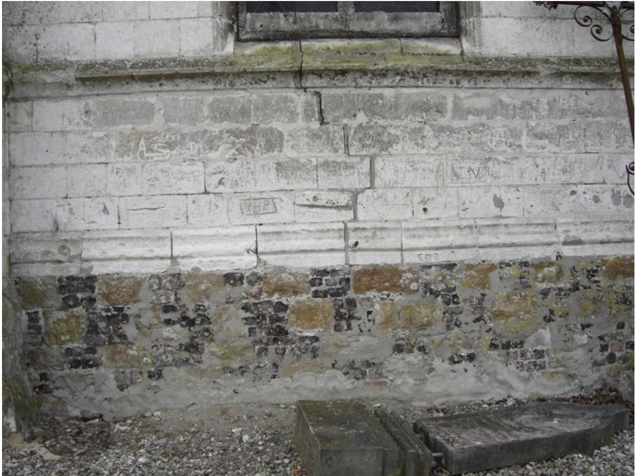
Vue sur le soubassement du choeur.
