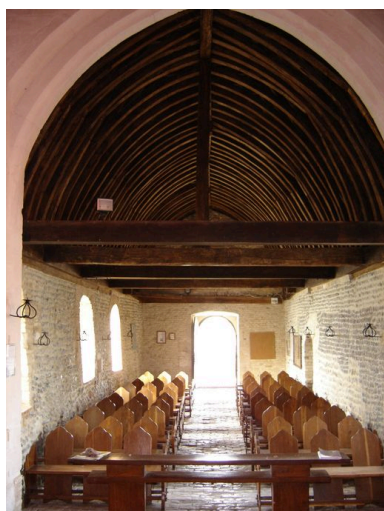
Vue intérieure de la nef depuis l'est. Phot. Inès Guérin IVR22_20078005967NUCA
