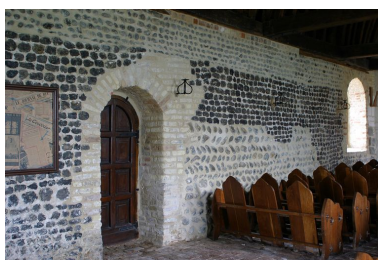
Vue détaillée de la maçonnerie mixte du mur intérieur nord. Phot. Irwin Leullier IVR22_20078000131NUCA
