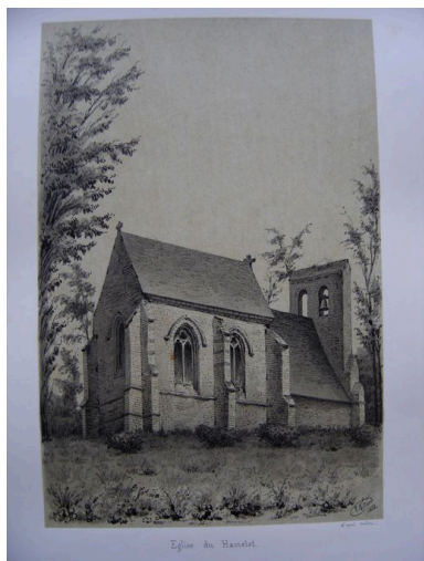
Dessin de la chapelle du Hamelet depuis le sud-ouest en 1868 par Gillard. Phot. Inès Guérin IVR22_20058006295NUCAB
