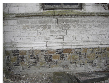
Vue sur le soubassement du chœur. Phot. Catherine Fourmond IVR22_20058001464NUCA
