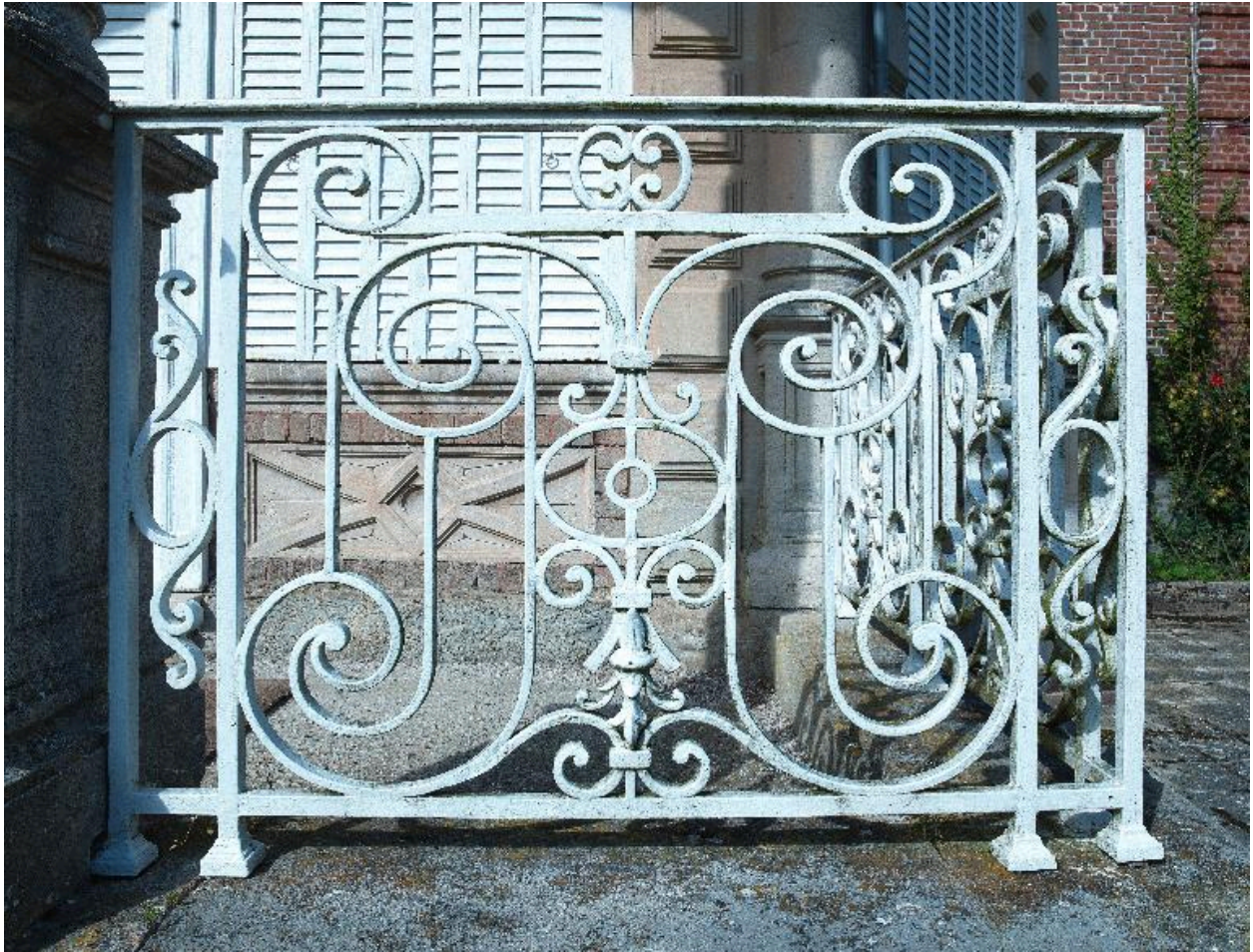
Vue du décor de ferronnerie du garde-corps de la terrasse.
