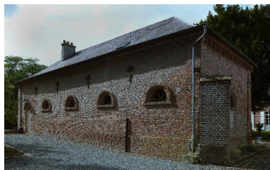
Les anciennes écuries. Phot. Marie-Laure Monnehay-Vulliet IVR22_20148000757NUC2A
