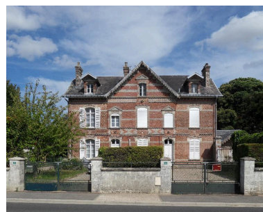
Vue des logements construits au nord. Phot. Isabelle Barbedor IVR22_20098010030NUCA
