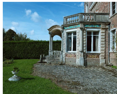
Vue du jardin d'hiver. Phot. Marie-Laure Monnehay-Vulliet IVR22_20148000748NUC2A
