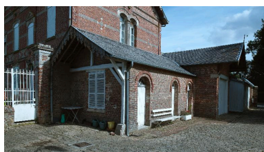
Les anciennes cellules de l'ancienne gendarmerie. Phot. Marie-Laure Monnehay-Vulliet IVR22_20148000758NUC2A
