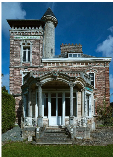
Vue du pignon sud du logis et du jardin d'hiver. Phot. Marie-Laure Monnehay-Vulliet IVR22_20148000747NUC2A
