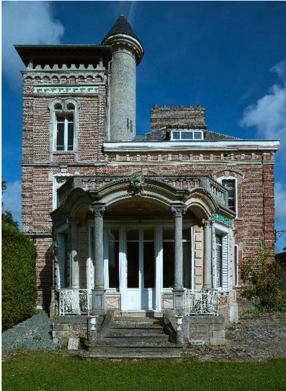
Vue du pignon sud du logis et du jardin d'hiver.
