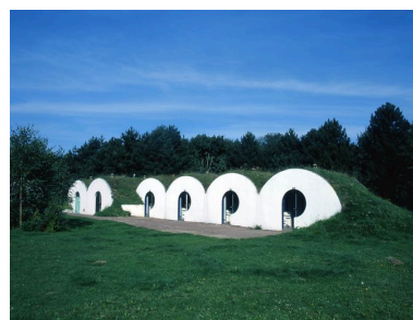
Elévation antérieure de bungalows. Phot. Marie-Laure Monnehay-Vulliet IVR22_20048000197XA
