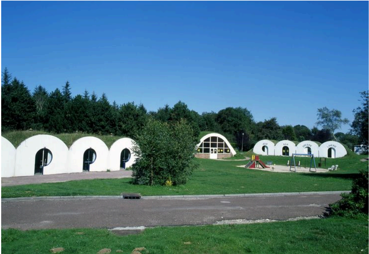
Vue d'ensemble des bungalows, salle commune, bungalows des services.
