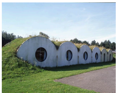
Elévation postérieure des bungalows. Phot. Marie-Laure Monnehay-Vulliet IVR22_20048000204XA
