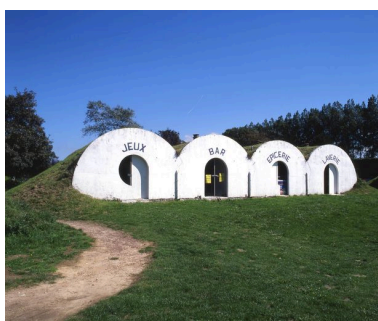
Les bungalows des services. Phot. Marie-Laure Monnehay-Vulliet IVR22_20048000202XA
