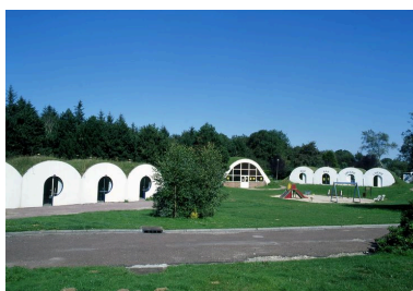
Vue d'ensemble des bungalows, salle commune, bungalows des services. Phot. Marie-Laure Monnehay-Vulliet IVR22_20048000201XA
