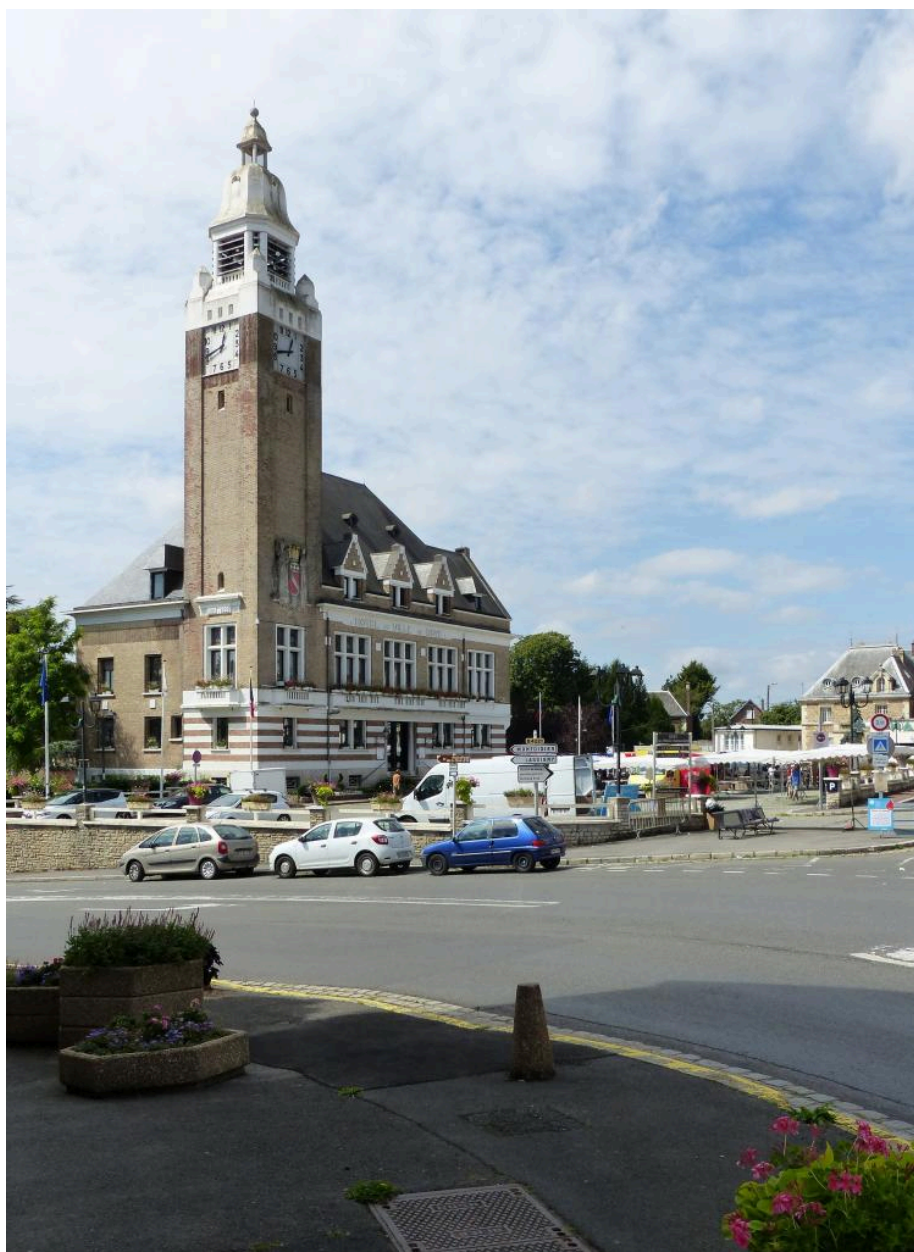
Vue de situation, depuis le nord-est.
