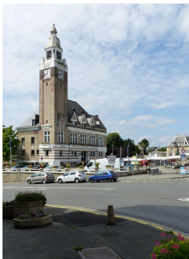
Vue de situation, depuis le nord-est.
