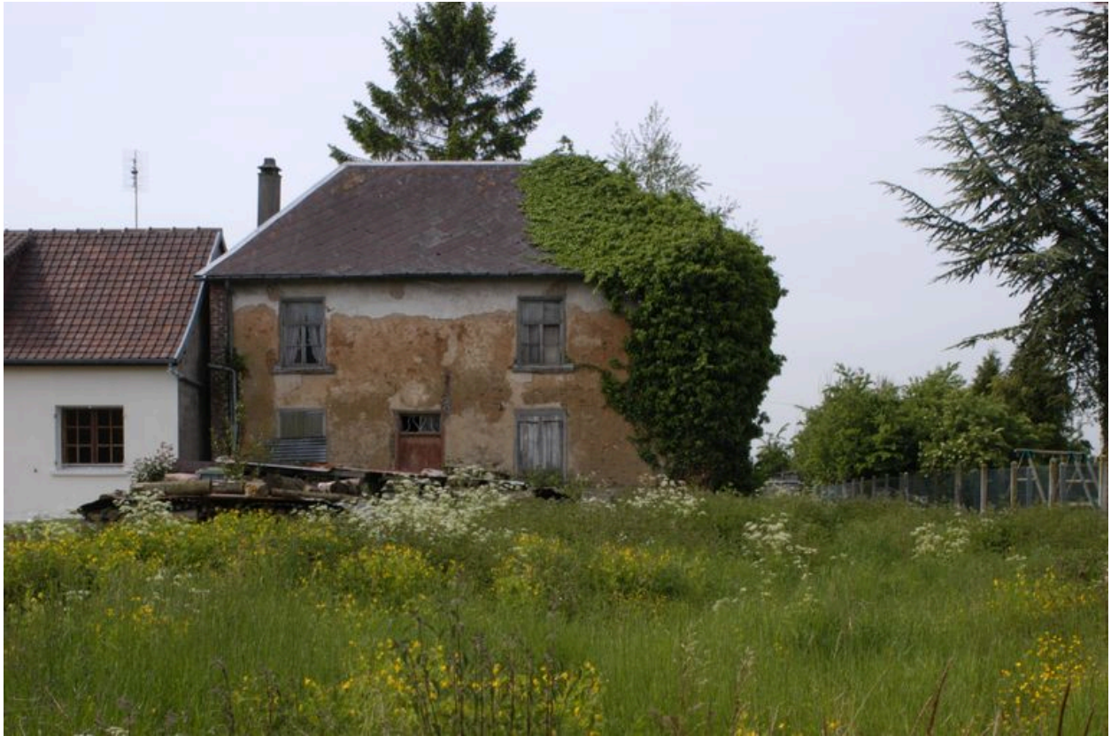
Vue de la façade nord.
