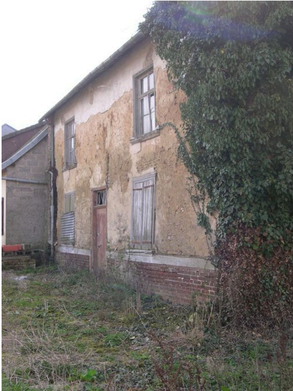
Détail sur la façade antérieure.
