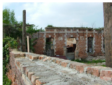
Bettencourt-Saint-Ouen, ancien château, 1777. Phot. Frédéric Fournis IVR22_20098005203NUCA
