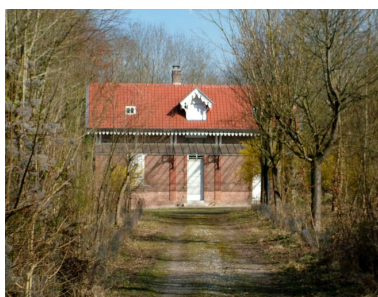
Bettencourt-Saint-Ouen, ancien chemin de l'Homme-mort. Maison forestière dite châtelet Monpetit, vers 1910. Phot. Frédéric Fournis IVR22_20118001031NUCA
