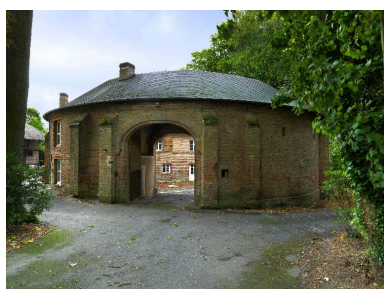
Flixecourt, communs de la demeure dite château Hesse, 1865. Phot. Thierry Lefébure IVR22_20128000843NUC2A
