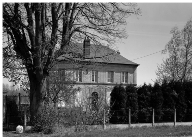
Elévation antérieure. Phot. Jean-Michel Perrin IVR22_19856000572X
