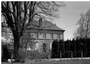
Elévation antérieure. Phot. Jean-Michel Perrin IVR22_19856000572X
