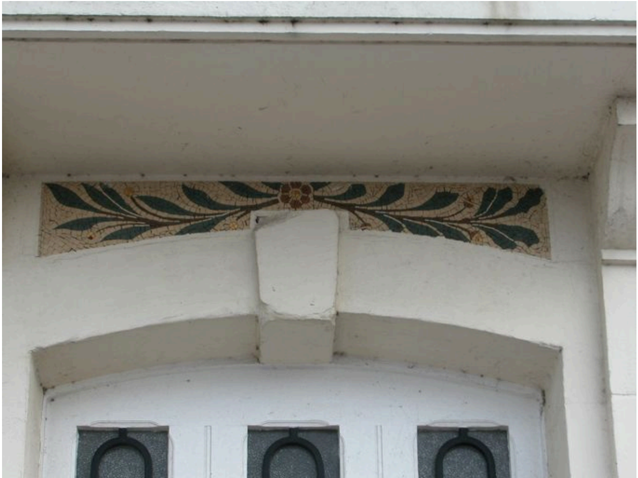
Détail du décor de mosaïque situé au dessus des baies (ici porte d'accès).
