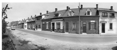
Vue des logements d'ouvriers (rue Marius-Sire), en 1991. Phot. Benoît Dufournier IVR22_19918000109Z
