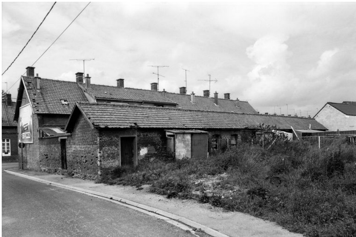
Vue des dépendances des logements d'ouvriers (90 à 102 rue Georges-Outrebon), en 1991.
