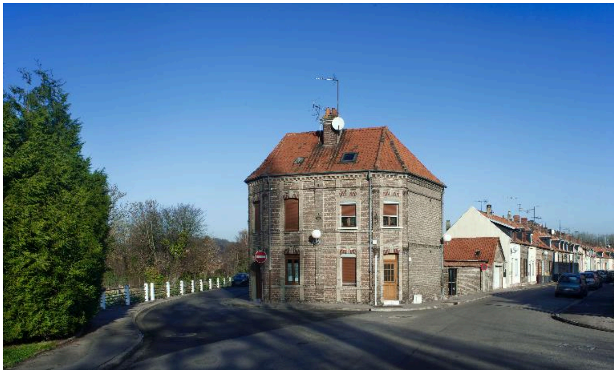
Logement de contremaître à l'entrée de la cité ouvrière Saint-Maurice.
