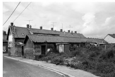
Vue des dépendances des logements d'ouvriers (90 à 102 rue Georges-Outrebon), en 1991. Phot. Benoît Dufournier IVR22_19918000028Z
