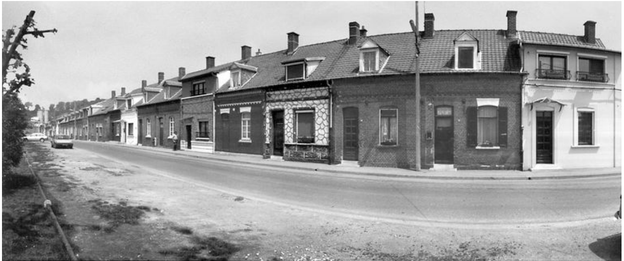
Vue des logements d'ouvriers (rue Marius-Sire), en 1991.
