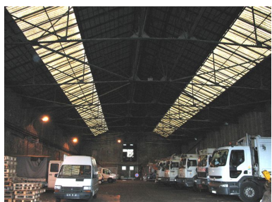
Vue générale de l'intérieur du garage. Phot. Clarisse Lorieux IVR22_20076005153NUCA
