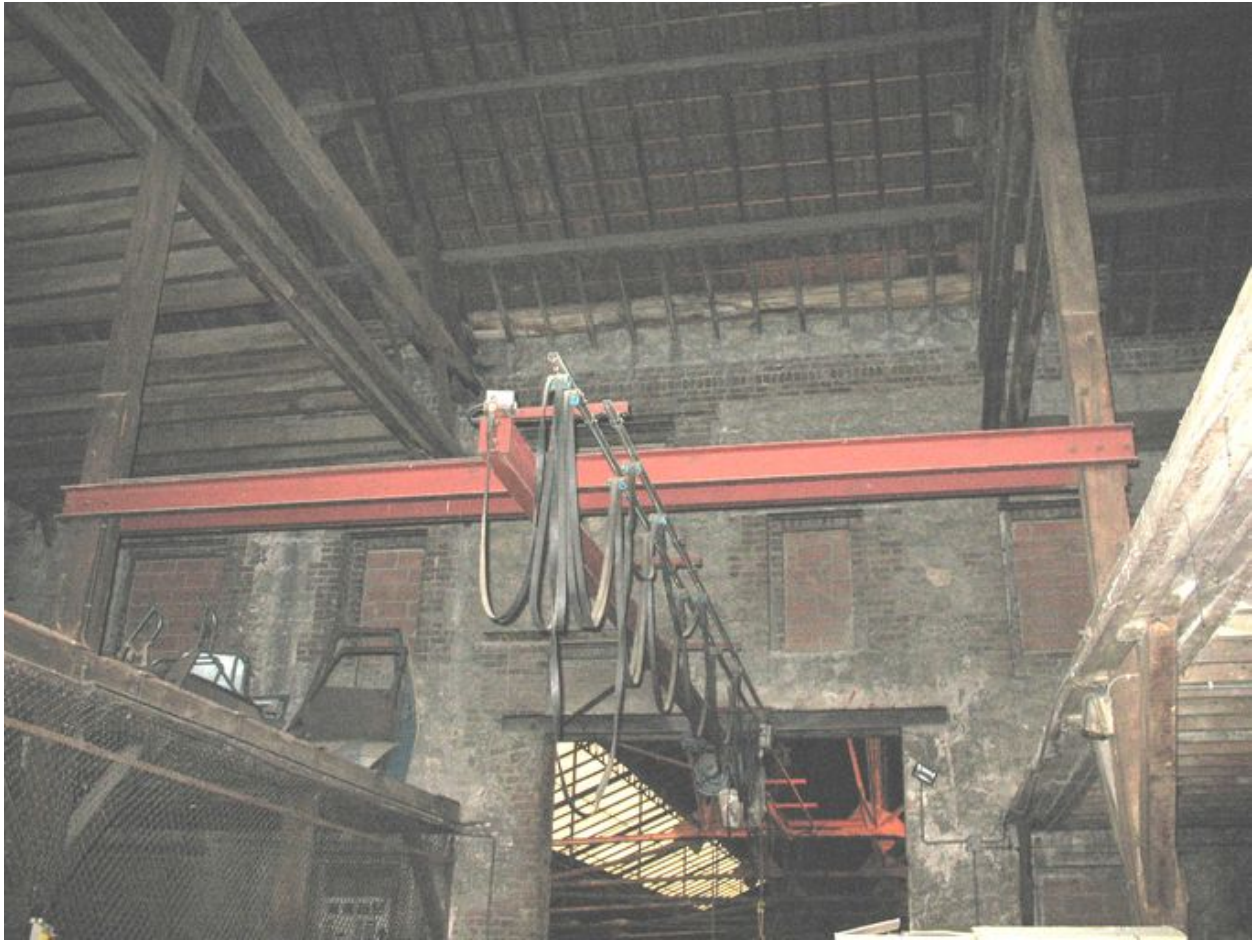
Premier étage de l'ancien relais de chevaux.
