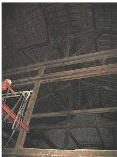
Charpente en bois dans l'ancien relais de chevaux. Phot. Clarisse Lorieux IVR22_20076005215NUCA
