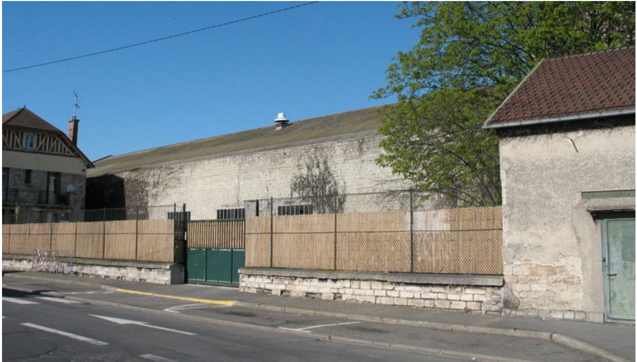
Vue des ateliers depuis la rue du Port.
