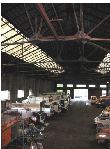
Intérieur des ateliers vu vers le nord. Phot. Clarisse Lorieux IVR22_20076005154NUCA
