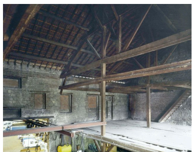
Plancher du premier étage de l'ancien relais de chevaux. Phot. Thierry Lefébure IVR22_20076000006VA
