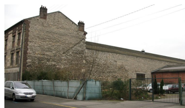
Les ateliers municipaux depuis le quai d'Aval.
