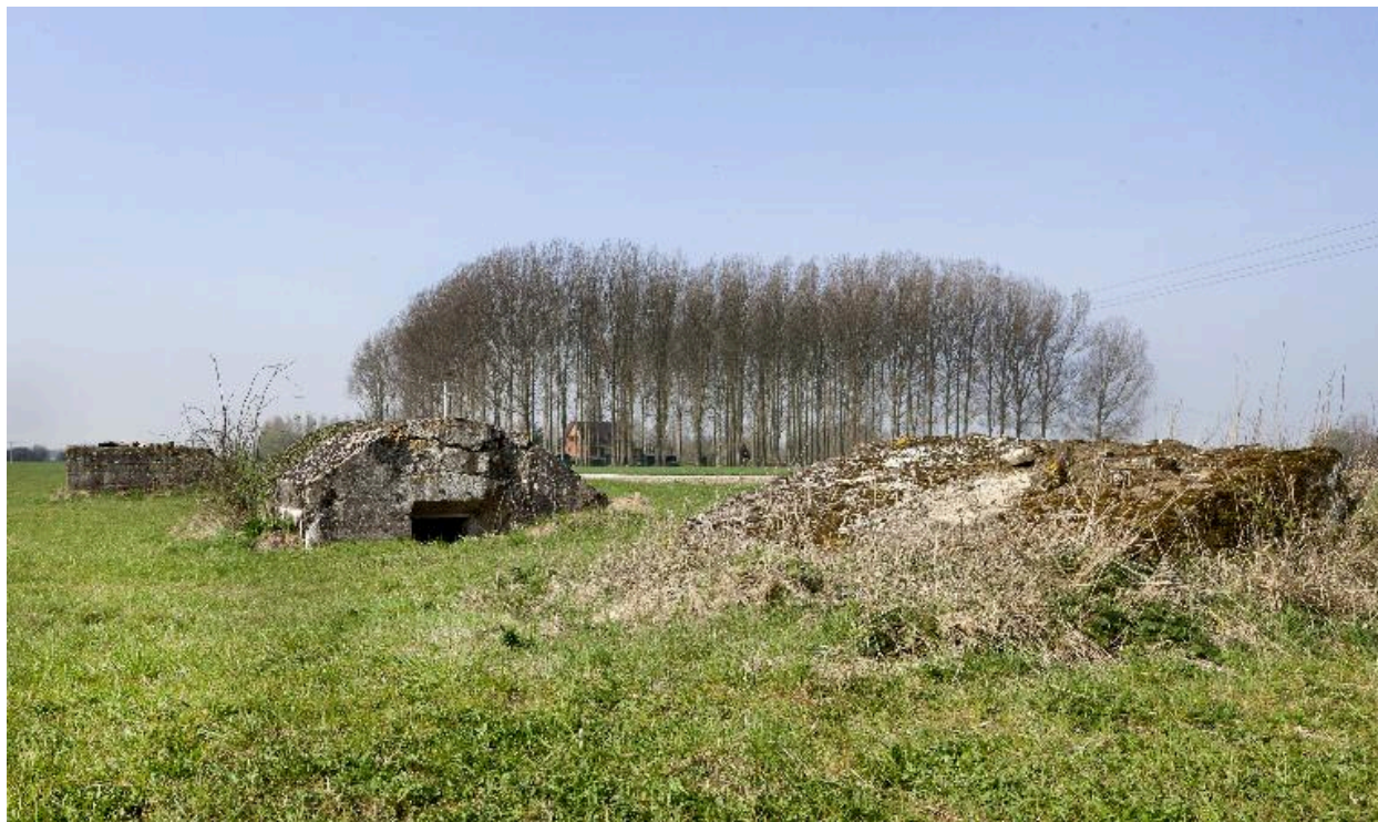
Vue générale des trois casemates, vers l'ouest
