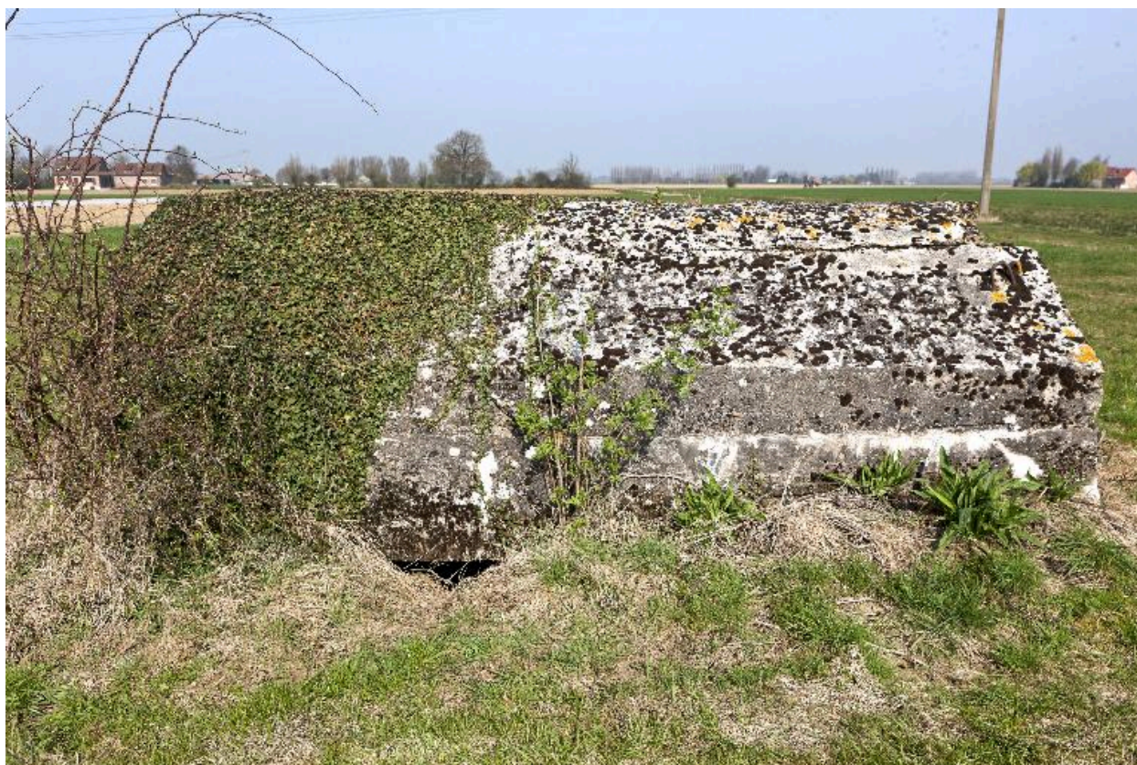
La casemate centrale, vue latérale vers le nord
