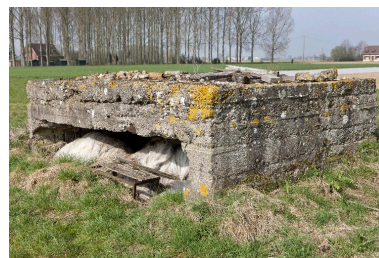
La casemate ouest, élévation sud Phot. Jean-Marc Ramette IVR31_20145904644NUCA
