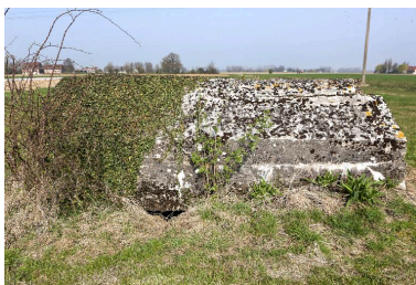
La casemate centrale, vue latérale vers le nord Phot. Jean-Marc Ramette IVR31_20145904642NUCA
