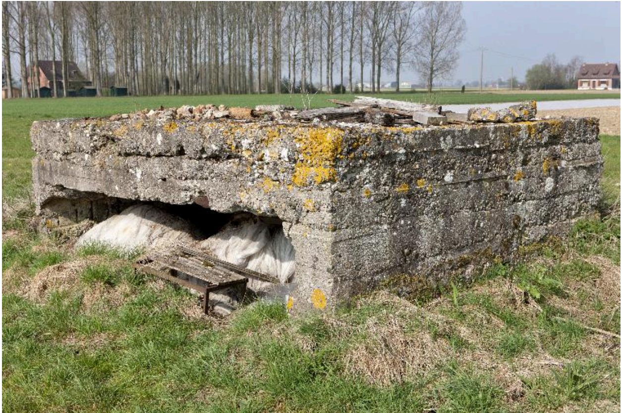
La casemate ouest, élévation sud
