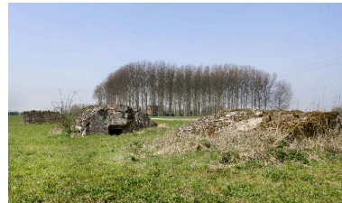
Vue générale des trois casemates, vers l'ouest Phot. Jean-Marc Ramette IVR31_20145904641NUCA
