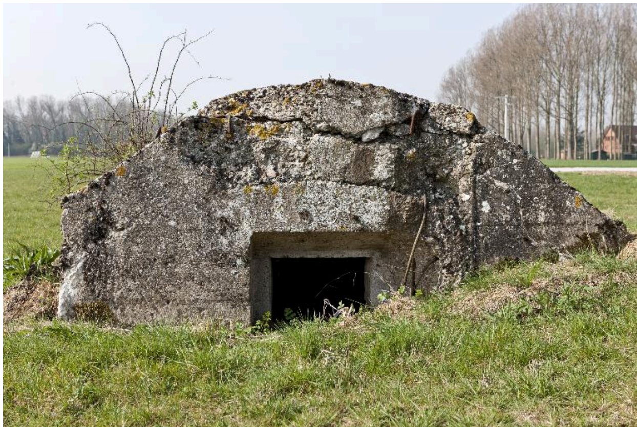
La casemate centrale, entrée sur pignon est
