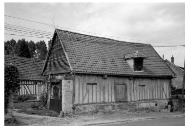
Grange. Elévation sur rue. Phot. Jean-Michel Perrin IVR22_19856000872X
