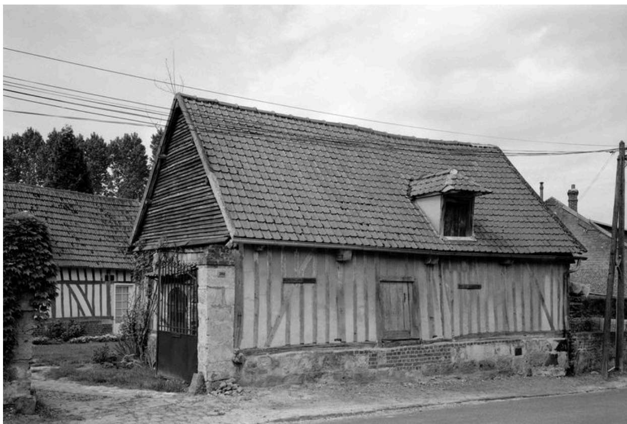
Grange. Elévation sur rue.
