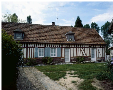
Logis. Elévation antérieure. Phot. Jean-Michel Perrin IVR22_19856000723XA
