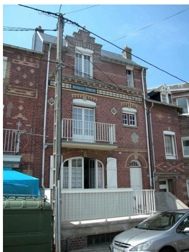
Vue d'ensemble depuis la rue. Phot. Elisabeth Justome IVR22_20048001679NUCA
