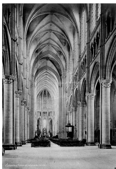
Vue du vaisseau central de la cathédrale, réalisée par Médéric Mieuxement vers 1890, et montrant les baies de l'abside sans verrières et obturées par une maçonnerie de brique (AMH Amiens).
