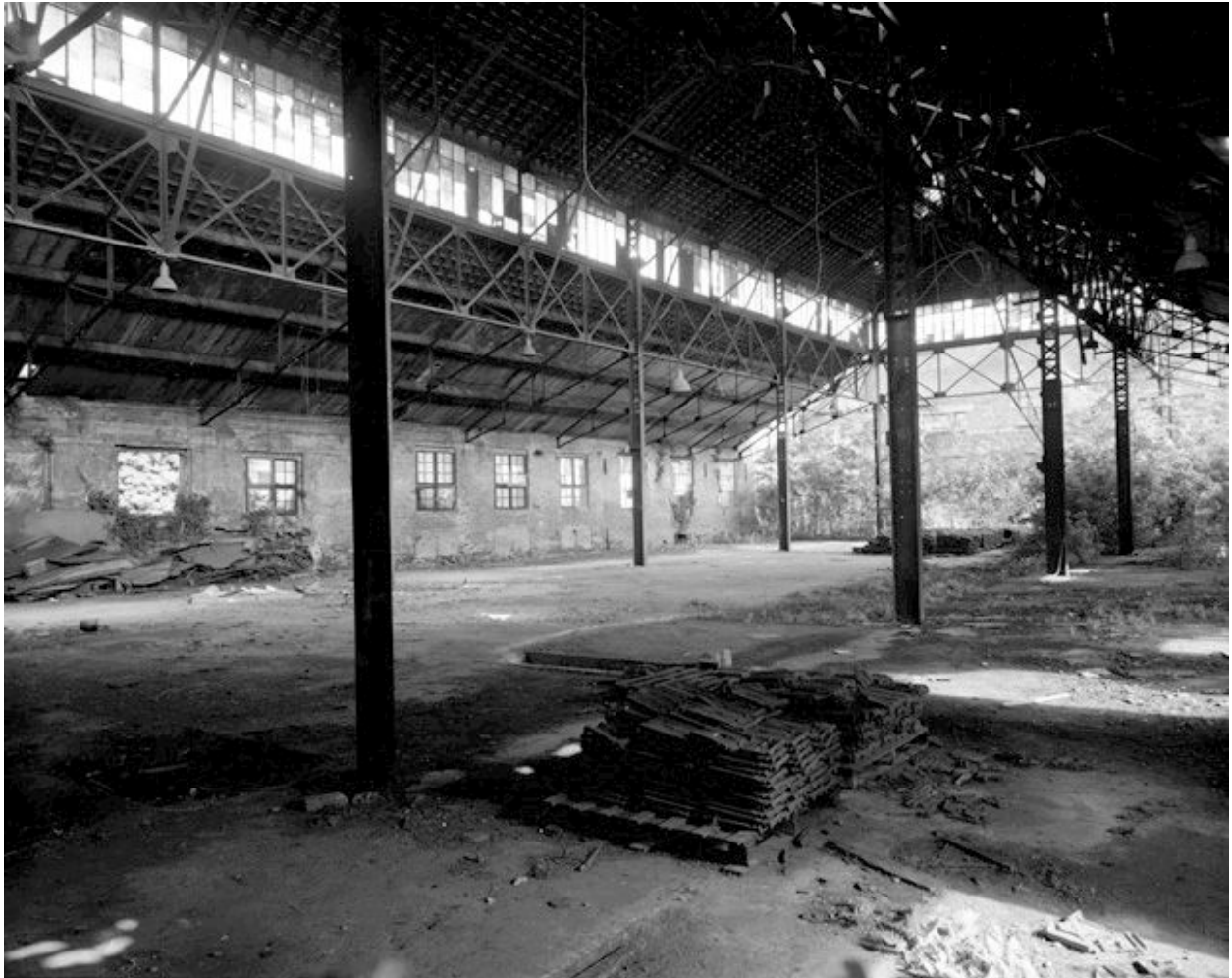
Atelier de fabrication, vue intérieure partielle, en 1988.
