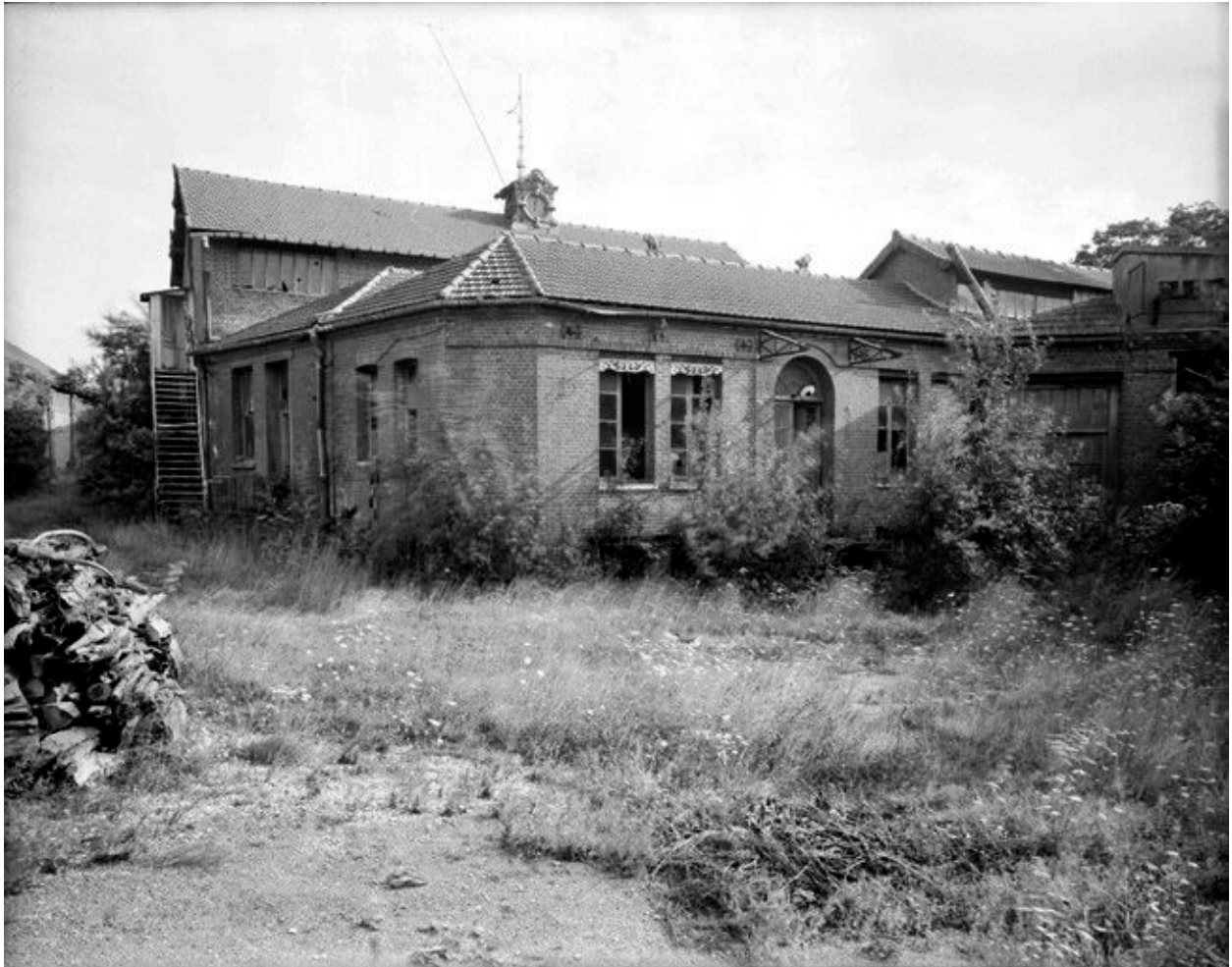
Atelier de fabrication, vue partielle en 1988.
