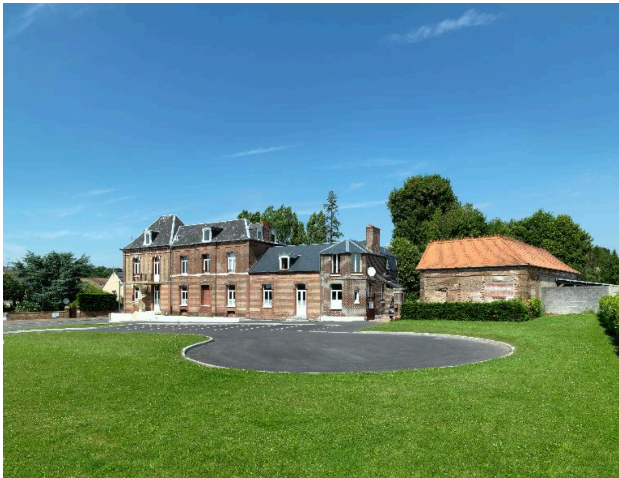
Ancien logement patronnal Caqueret.
