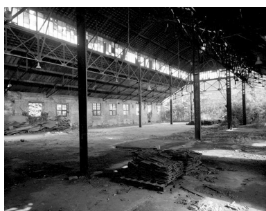
Atelier de fabrication, vue intérieure partielle, en 1988. Phot. Thierry Lefébure IVR22_19888000912V
