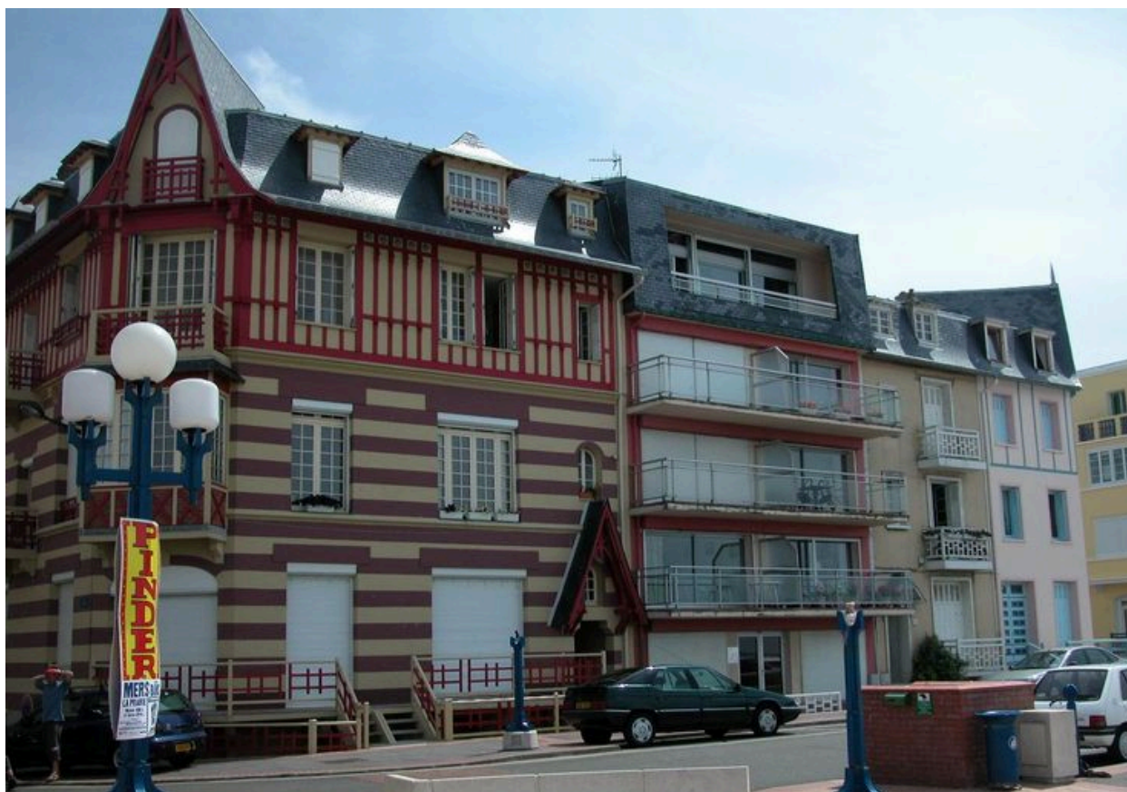
Vue d'ensemble du front de plage (îlot 18).
